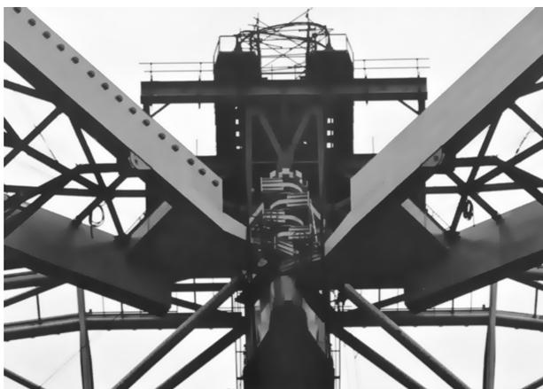
Abbildung 5-117: Drehzapfen am First mit zwei montierten Segmenten
