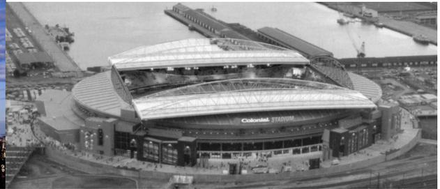
Abbildung 5-88: Stadion von oben mit fixem Dach (dunkler) und beweglichem Dach (heller dargestellt)
