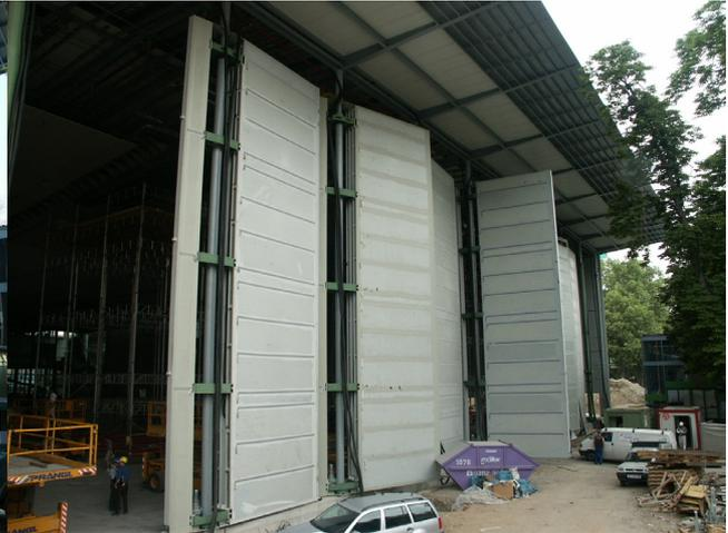
Abbildung 5-52: Torflügel nach der Montage
