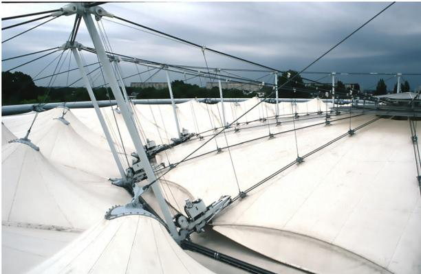
Abbildung 5-108: Seilbinder mit geschlossener Dachhaut. Seiltrommel und Spannmechanismus jeweils am Fuß der Luftstützen
