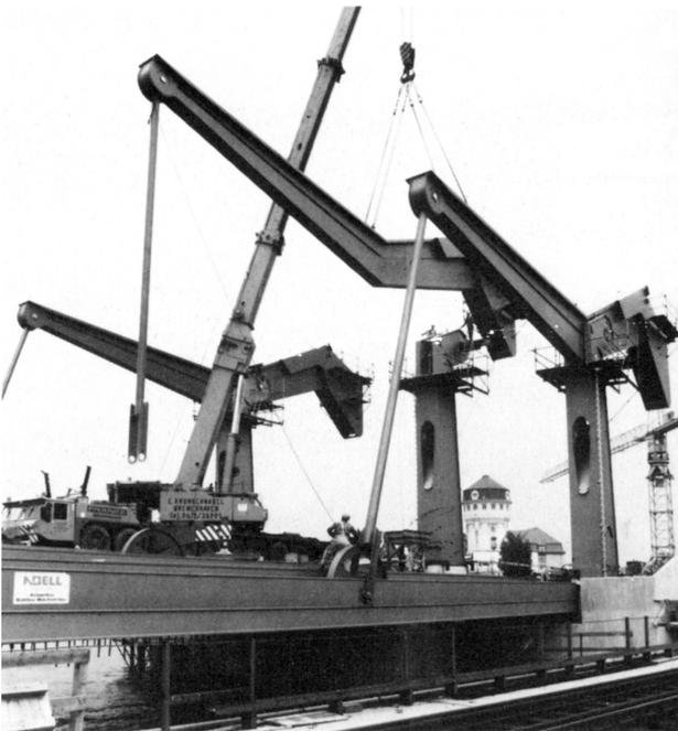
Abbildung 5-10: Montage der Waagbalken
