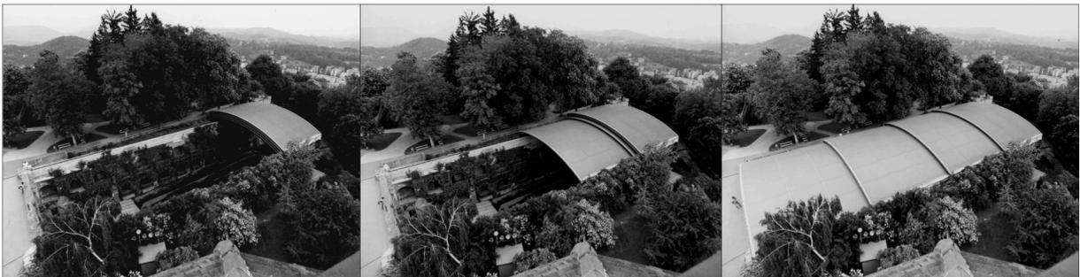
Abbildung 5-73: Schließen des Daches
