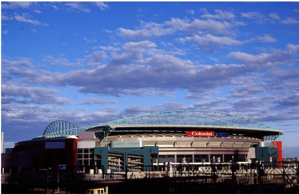
Abbildung 5-87: Außenansicht mit einer beweglichen Dachhälfte über dem fixen Dach
