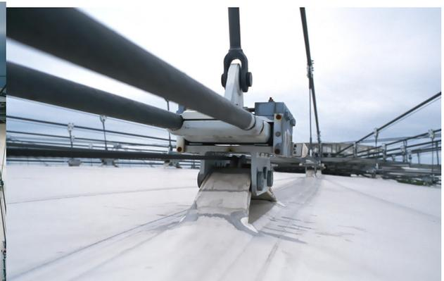
Abbildung 5-109: Aufhängung der Dachhaut mit Gleitschlitten am Untergurt des Seilbinders
