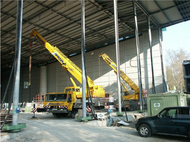
Abbildung 5-51: Angeln der Drehtore mit unteren Lagerblechen
