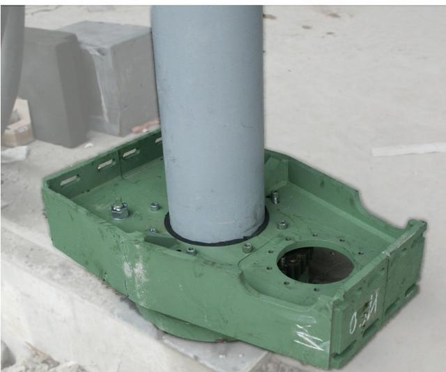
Abbildung 5-55: drehbares Lager mit fixer Drehachse und Bohrungen für den Getriebemotor
