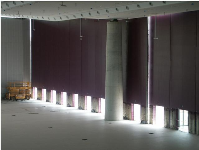
Abbildung 5-45: Schiebewandsegmente von Innen
