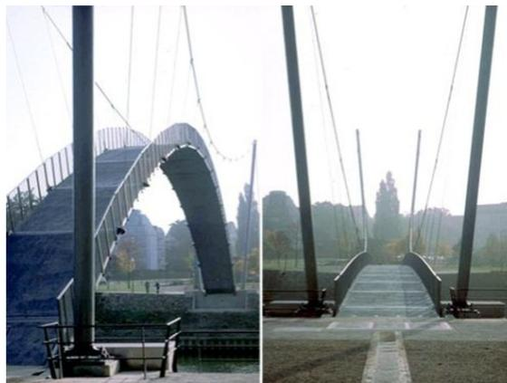
Abbildung 5-29: Brücke in Hoch- und Tieflage
