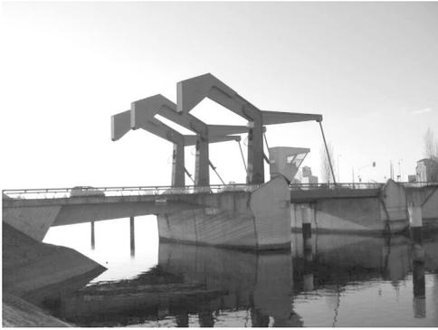
Abbildung 5-8: Ansicht der beiden Brücken mit den drei Waagbalken
