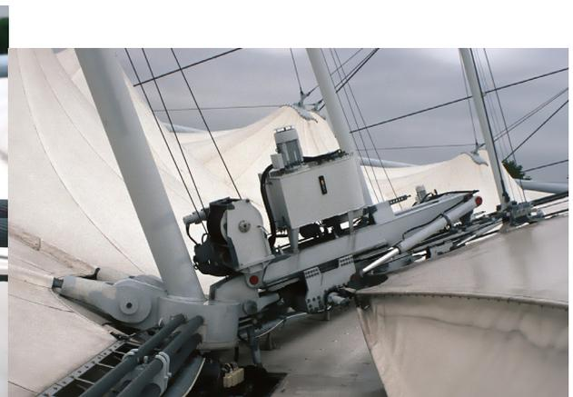
Abbildung 5-111: Spannmechanismus
