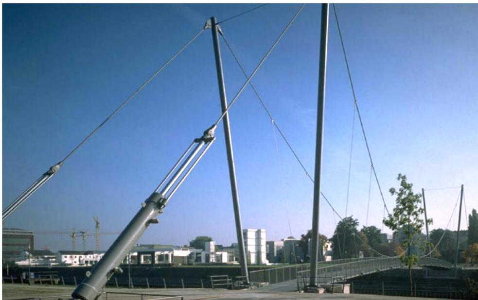
Abbildung 5-30: Ansicht der Brücke mit Hydraulikzylindern an den Rückverankerungen
