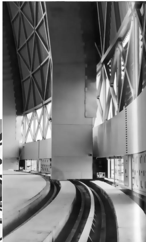
Abbildung 5-118: Lagerung der Segmentfußpunkte auf Schienen
