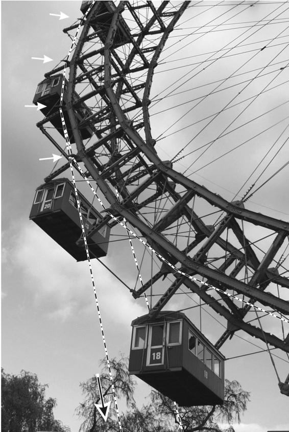
Abbildung 5-135: Antriebsseil mit Umlenkrollen
