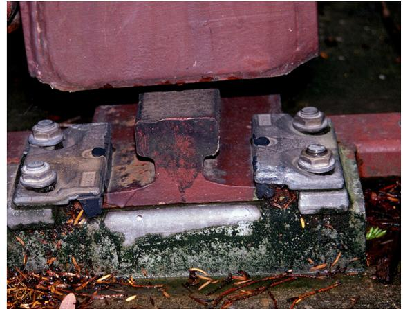
Abbildung 5-77: Schienenprofil und -befestigung
