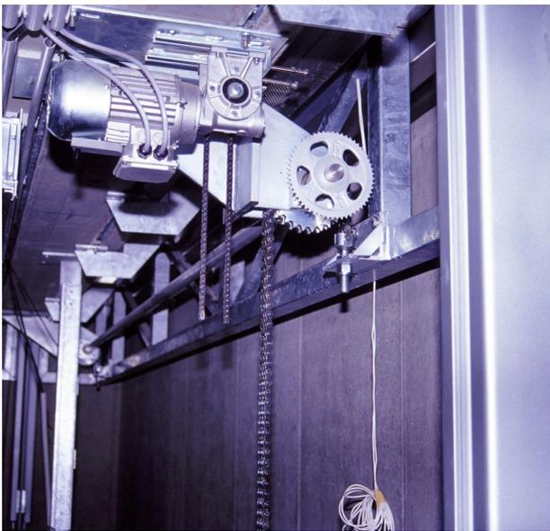
Abbildung 5-41: Aufhängung des Fachwerkträgers im Keller (Hubketten mit Umlenkritzel, Welle, Antriebsritzel und Getriebemotor mit ausgehängter Antriebskette)
