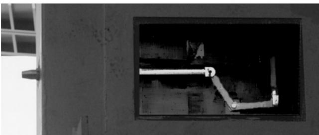
Abbildung 5-61: Arretierungsbolzen mit Winkelhebel
