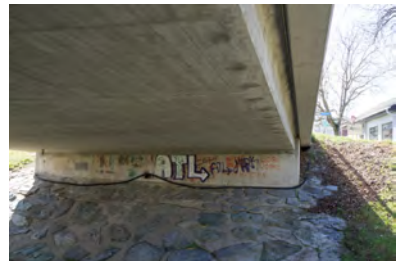
Randbalken, Untersicht Kragplatte
