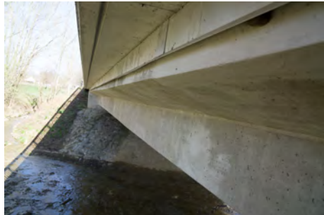
Randbalken, Untersicht Kragplatte
