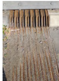
Abbildung 1.4.: Typische Schadensbilder von Lager- und Fahrbahnübergangskonstruktionen 2
