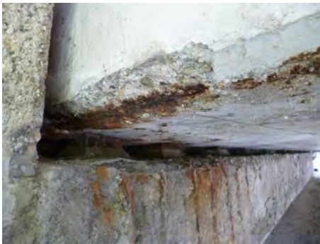
Abbildung 1.4.: Typische Schadensbilder von Lager- und Fahrbahnübergangskonstruktionen 2
