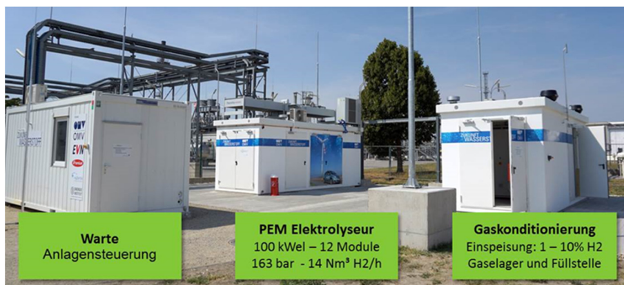
Abbildung 1: wind2hydrogen – Hochdruck-PEM-Elektrolyseanlage
