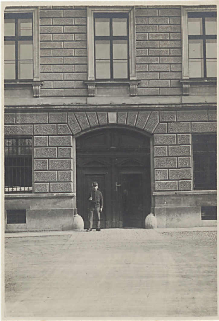
Abb.: Auch die Hofeinfahrt zur Alten Technik wurde von einem Soldaten bewacht (StLB).
