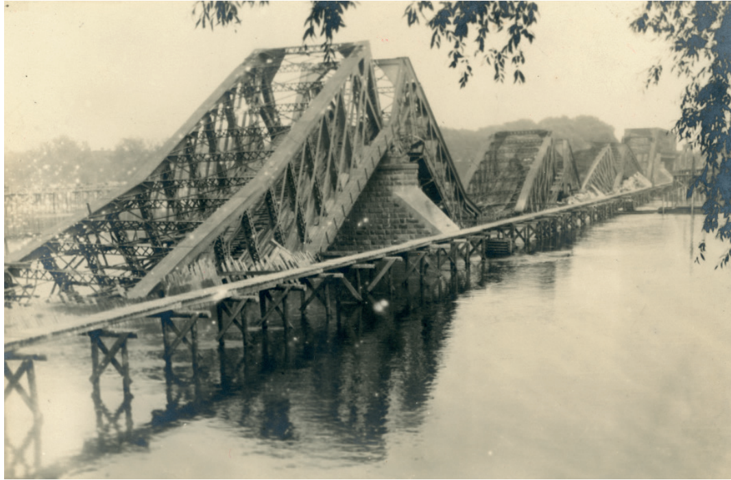
Abb.: Foto der gesprengten Weichselbrücke von Iwangorod, 1915, aufgenommen von Hans Löschner (ATUG).
