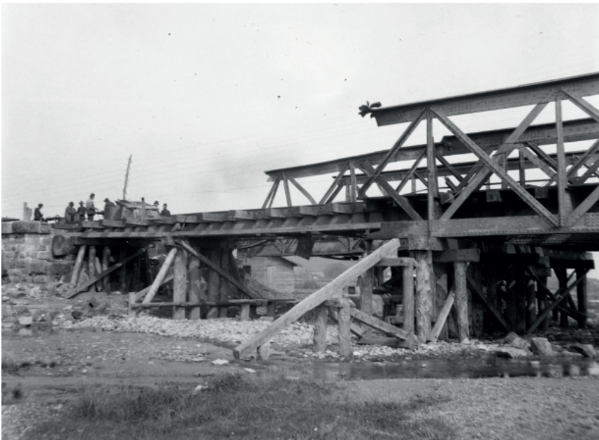
Abb.: Reparaturarbeiten an einer gesprengten Eisenbahnbrücke in Galizien im September 1915, aufgenommen von Hans Löschner (ATUG).
