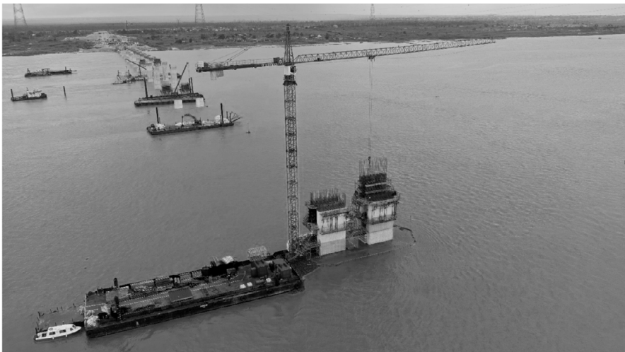
Abb. 21: Turmdrehkran und Materialponton in Achse 260
