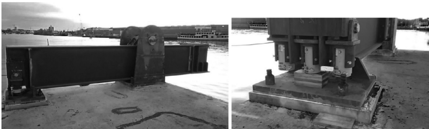
Abb. 24: Primary support - Wippen-Konstruktion
