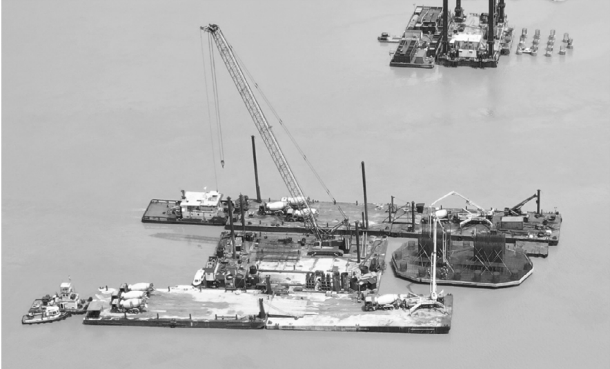
Abb. 20: Zwei Transport-Pontons und zwei Pumpen-Pontons im Parallelbetrieb zur „offshore“ Betonage einer Pfahlkopfplatte
