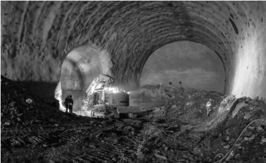
Abb. 8: Vortrieb in der Nothaltestelle St. Jodok (Mittelstollen und Abluftquerstollen)
