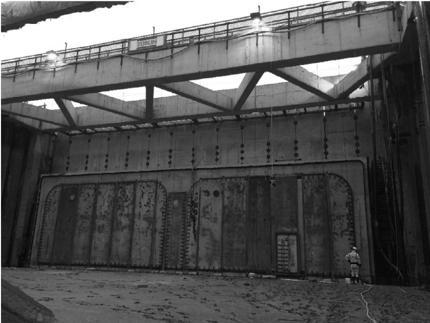
Abb. 15: Ende des TE 3 in der trockengelegten Baugrube
