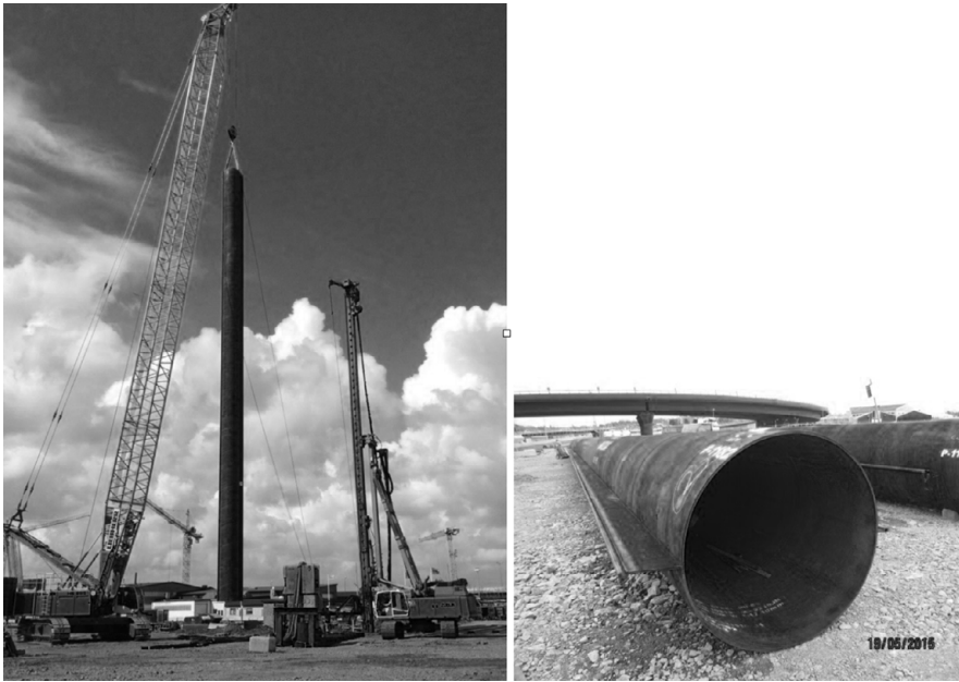
Abb. 4: Einbringen der Rohre der Pipe-to-Pipe-Wand
