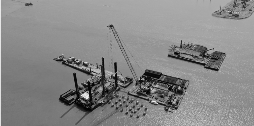
Abb. 8: Herstellung der Großbohrpfähle Achse 270 mit Hubinsel ILSE Julius Berger
