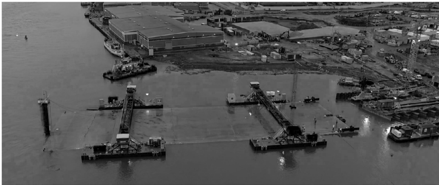
Abb. 19: Tunnелеlement 1 während des Einschwimmvorgangs
