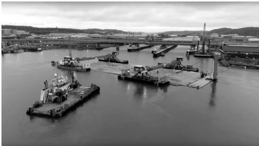
Abb. 12: Einschwimmvorgang TE 1
