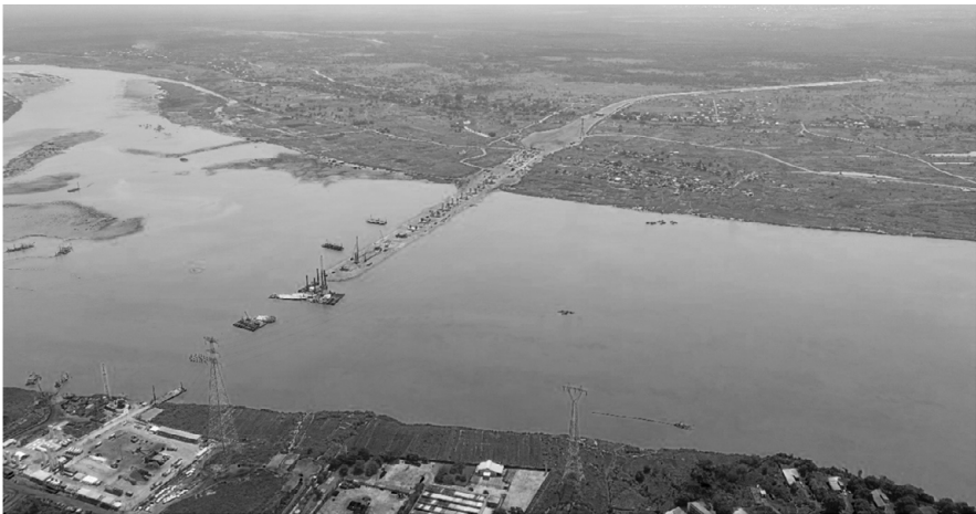
Abb. 18: Temporärer Arbeitsdamm zur Herstellung des Unterbaus entlang des „West-Approaches“
