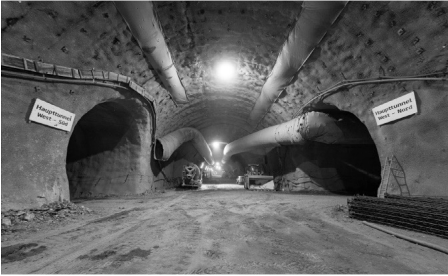
Abb. 7: Querkaverne St. Jodok mit den seitlichen Haupttunnelröhren
