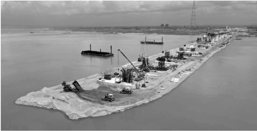
Abb. 15: Gründung und Herstellung der Unterbauten „West Approach“
