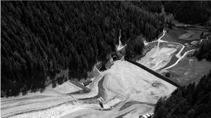
Abb. 11: Deponie Padastertal mit der Baustelleneinrichtungsfläche vor dem Baubeginn des Bauloses H51 „Pfans – Brenner“
