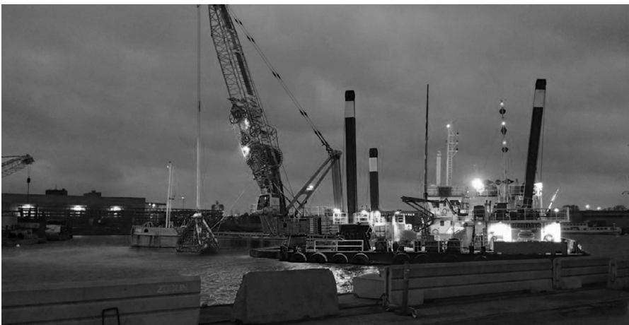
Abb. 29: Verfüllarbeiten am Tunnelement
