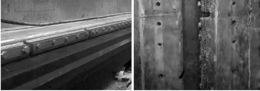
Abb. 31: "GINA-Gasket" Installation / im komprimierten Zustand
