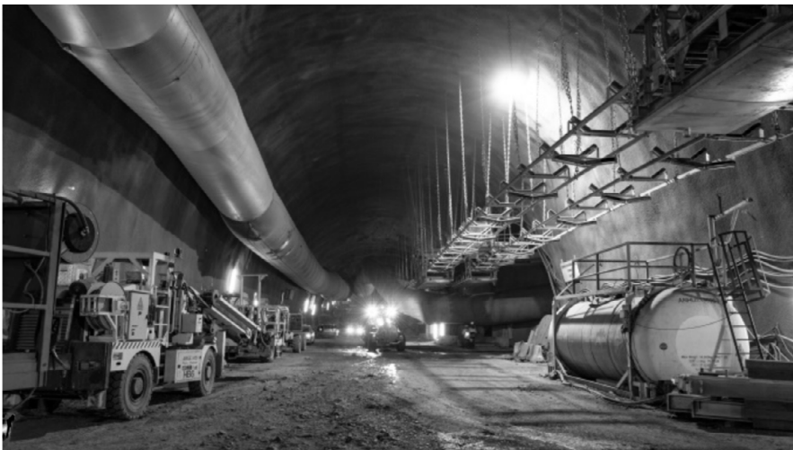
Abb. 12: Abzweigekaverne am Fußpunkt des Zugangstunnel Wolf (Montage Förderbänder)
