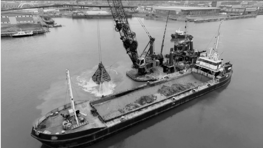
Abb. 8: Nassbaggerarbeiten im Fluss
