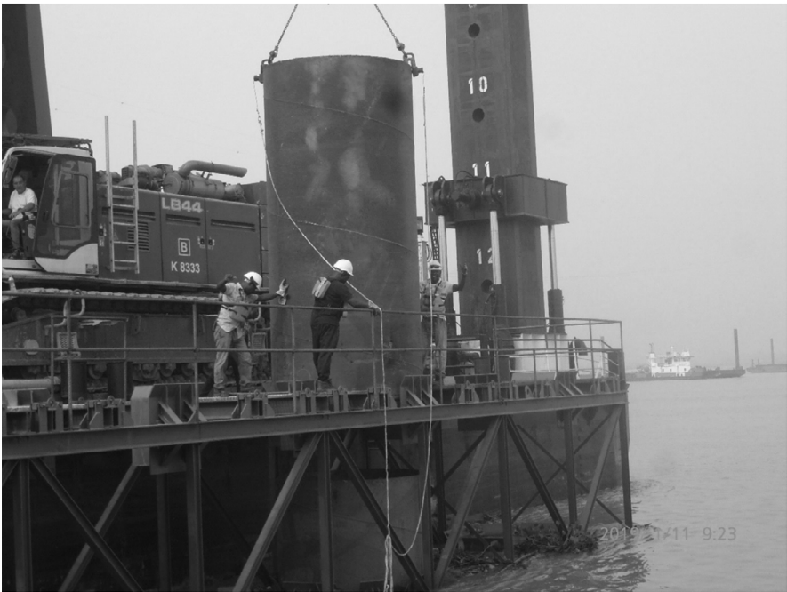
Abb. 9: Großbohrpfähle Achse 260: Einsetzen des Stahlrohres
