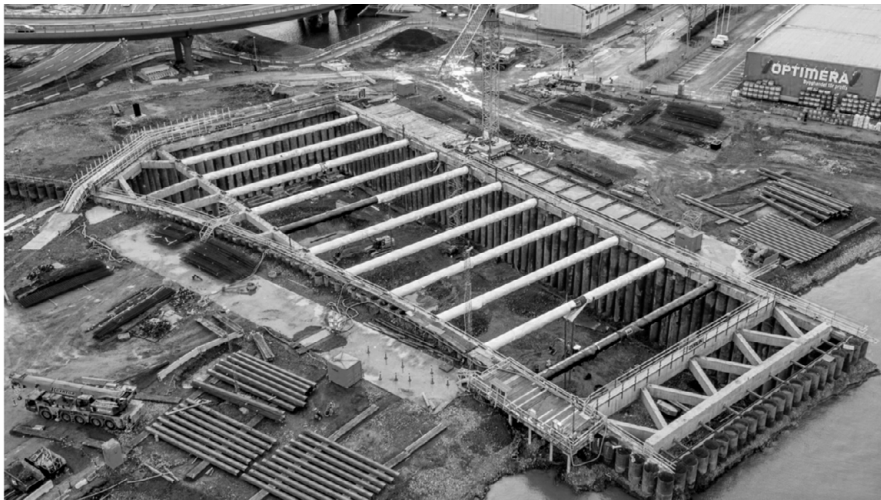
Abb. 5: Baugrube Marieholm C&C im Februar 2016
