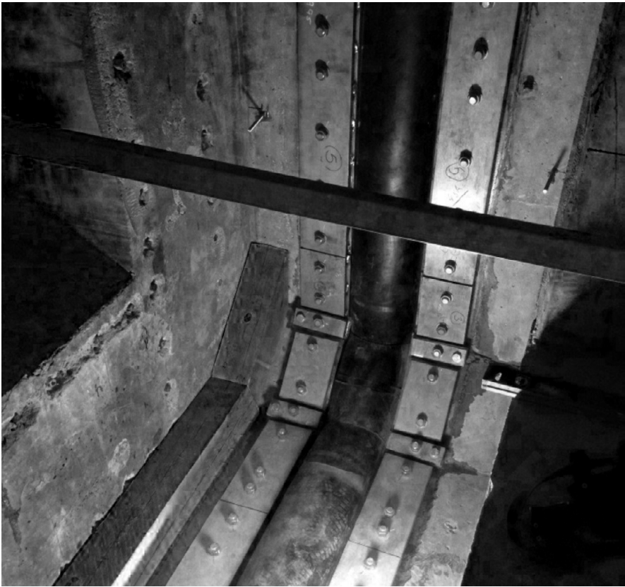
Abb. 32: Immersion Joint mit installiertem Omega-Fugenband
