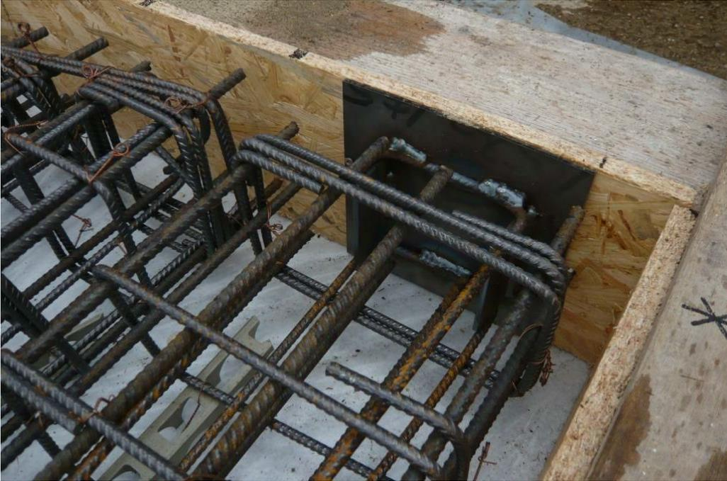
*Abbildung 88. Ansicht der Stahleinbauteile für Lasteinleitung*
