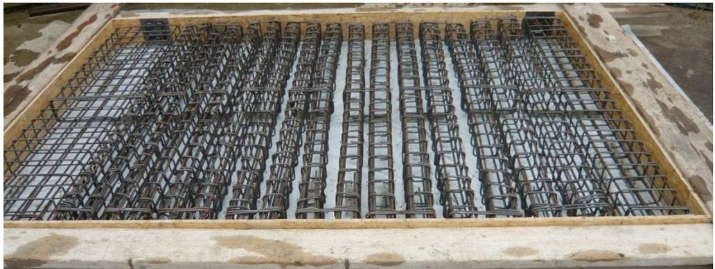
*Abbildung 87. Ansicht der Bewehrung in der Schalung ohne Trenneinlagen*
