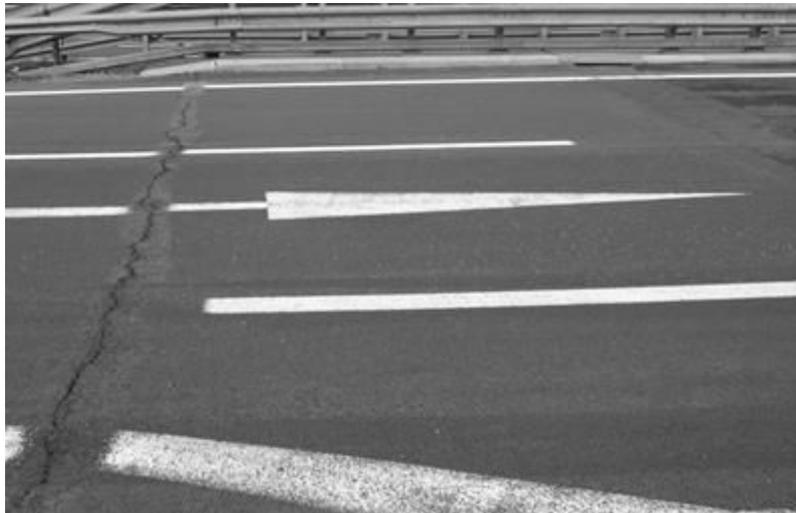
*Abbildung 57. Risse im Bereich Übergang Schleppplatte – freie Strecke
