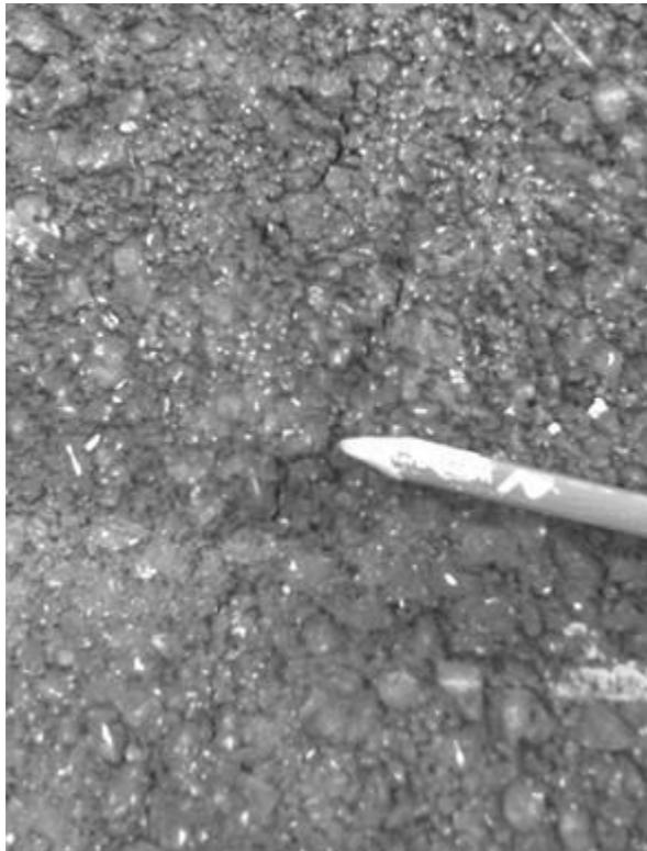
*Abbildung 71 Riss 3 – Rissweite ~0,4 mm*
