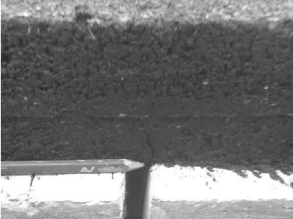
*Abbildung 76 Riss 8 - Rissweite ~1,5 mm*
