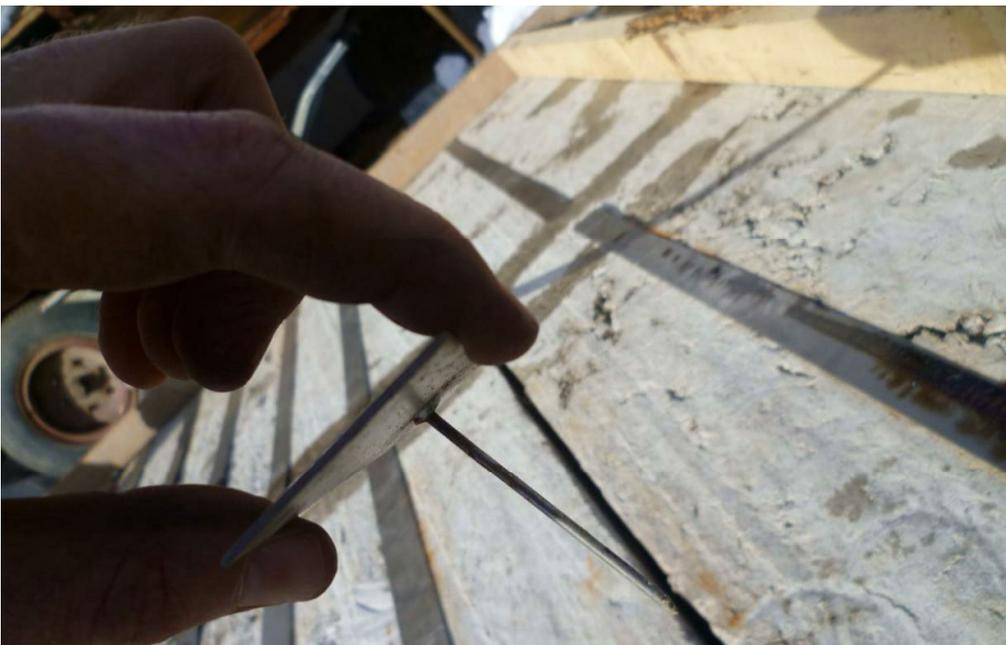
*Abbildung 91. Fugenabdeckung mittels Blechstreifen mit Dorn*
