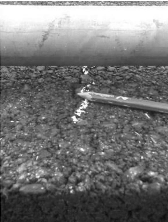
Abbildung 73 Riss 5 – Rissweite ~1 mm
