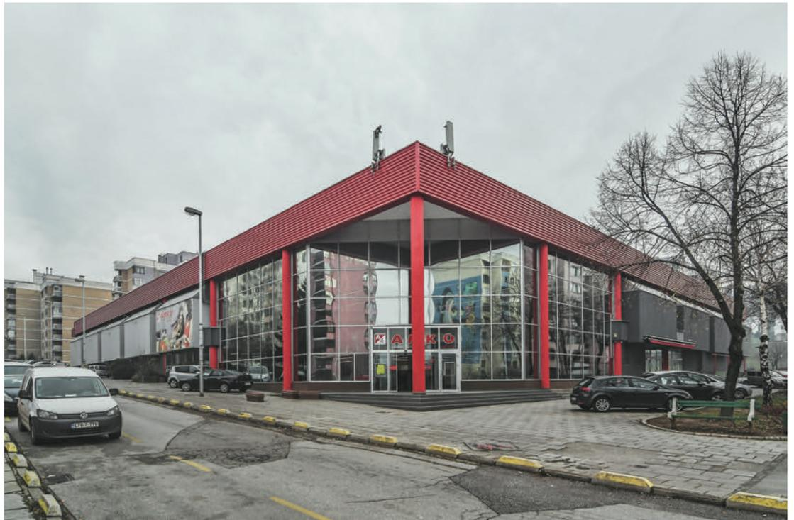
Die Stahlfachwerke, die ursprünglich sichtbar waren, sind heute mit Stahlblechen verkleidet. Der Hauptzugang befindet sich jetzt genau an der Ecke, die zum Forum der Jugend hin ausgerichtet ist, und statt der früheren zwei Zugänge wurde die Fassade durchgezogen. Damit der jetzige Eingang optimal funktionieren kann, wurden die skulpturalen Treppen im Innenraum entfernt. Statt der grünen Fachwerke dominieren heute rote Stahlbetonstützen (Abb.46).
