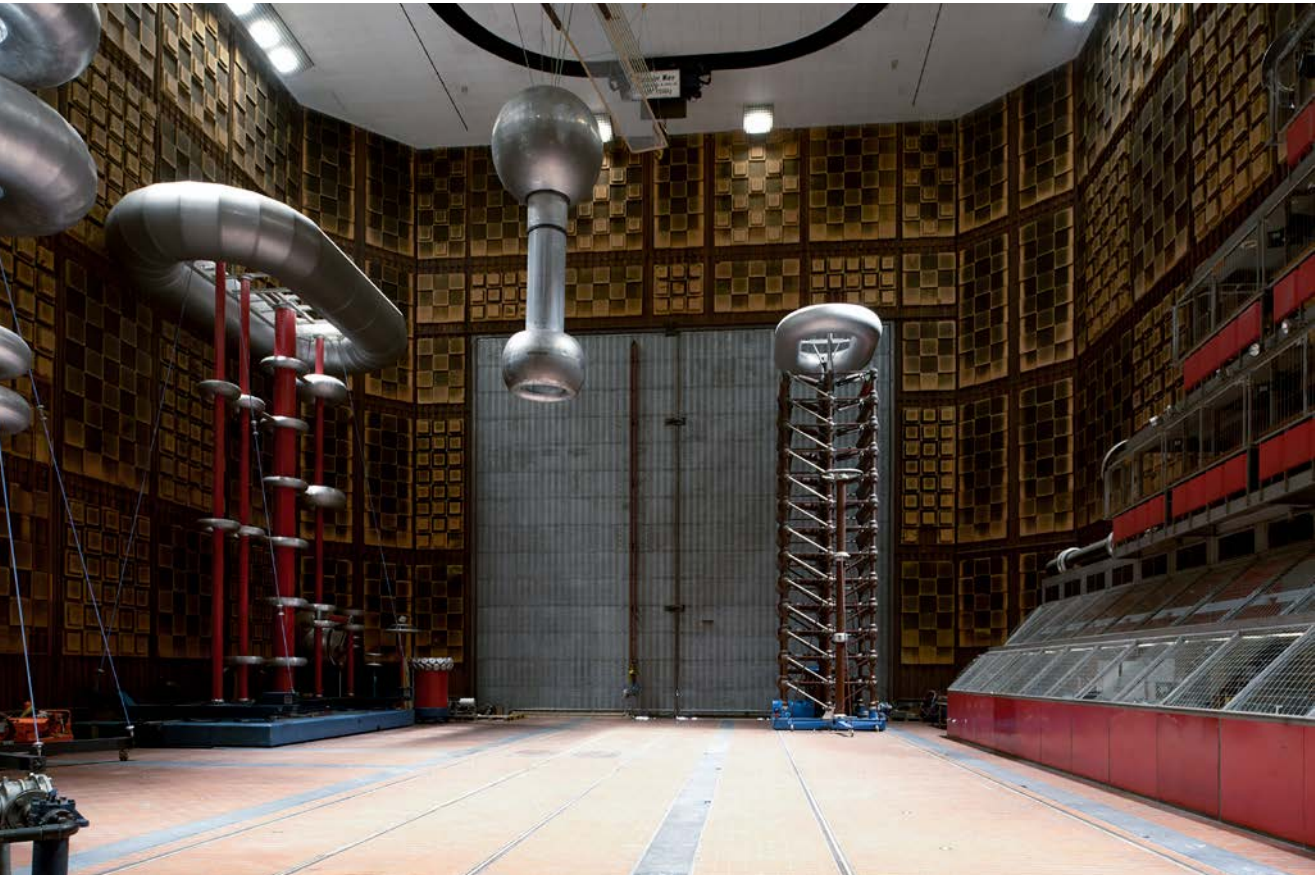
Abb.: Hochspannungshalle – Innenansicht (Foto: H. Tezak)
