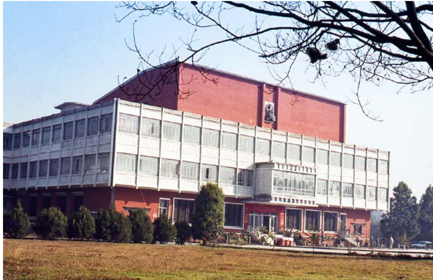
Abb. 18.2: Das Gebäude der Royal Nepal Academie, 1983, Neubau in Kathmandu.
