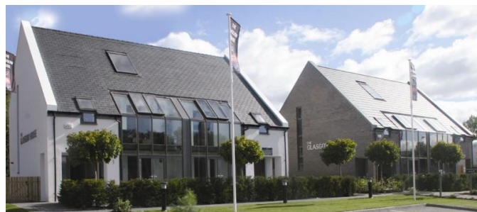
Abb. 2 Foto: links: Massivbau, rechts: Leichtbauweise [3]
