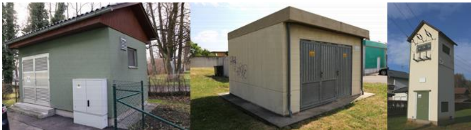
Abbildung 1: Beispiele für freistehende Transformatorstationen v.l.n.r.: Sonderstation, Betonfertigteilstation, Turmstation
