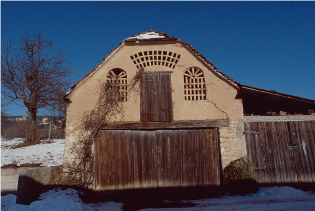
Abb. 243 Dieses Ziegelgitter findet sich in einem kleinen Gebäude etwa 100m nördlich, quasi knapp oberhalb der Ruinen der Casa Rustica in Löffelbach bei Hartberg. Das Haus hatte im Dachgeschoss ein Heulager und unterhalb eine sehr breite Einfahrt. Diese diente wahrscheinlich für ein sehr breites landwirtschaftliches Fahrzeug. Für die Ziegelgitter im Giebelfeld hatte jemand eine eigenartige Idee für ihre Gestaltung. Die mittig angeordnete Tür über der breiten Einfahrt, die bis in das Giebeldreieck reicht, sollte einen Sturz aus gemauerten Ziegeln erhalten. Allerdings wollte der Planer diesen Druckbogen entmaterialisieren. Gewöhnlich wurden früher hierfür keilförmige Steine oder Ziegel zu einem Bogen über der Türöffnung zu einem Segmentbogen oder zu einem scheinrechten Bogen zusammengesetzt, um so den Druck des Mauerwerks oberhalb zu den Seiten abzuleiten. Hier verwandelte der Planer den "Segmentbogen" in ein Ziegelgitter, das in der Regel eine
