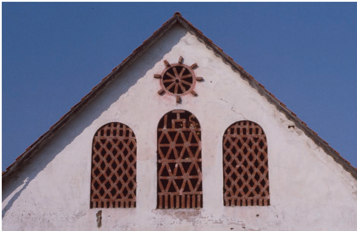
Abb. 120 Der Giebel in Albersdorf bei Gleisdorf besteht aus vier vorgefertigten Maueröffnungen. Unter dem First gibt es eine aus Ziegeln gemauerte Rosette. Bei ihr wurden schon während des Baues acht leicht aus der Fassade vortretende Ziegel seitlich eingemauert. Erstaunlicherweise wurden dann aber neun Ziegel etwas zurückweichend angebracht.
