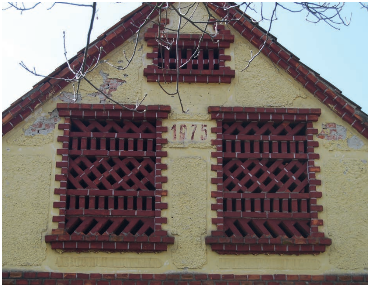
Abb. 63 Im gepflegten Bachsdorf südlich von Lebring-St. Margarethen in der Dorfstraße 37 findet sich eines von einem ganzen Ensemble unterschiedlicher Ziegelgittern in landwirtschaftlichen Bauten. Dieses hier ist wieder ein tragendes Gitter, bei dem die Öffnungen Pfeile nach oben und unten ergeben – eventuelle ein Hinweis auf gute Verbindungen zwischen den Bewohnern und himmlischen Mächten als Hinweis an den Teufel. Das Gitter wurde auf der Außenseite verputzt und dann im Farbton von Ziegeln gefärbt. Manche der Doppelpfeile wurden unter dem Druck von oben etwas deformiert. Foto: 2020
