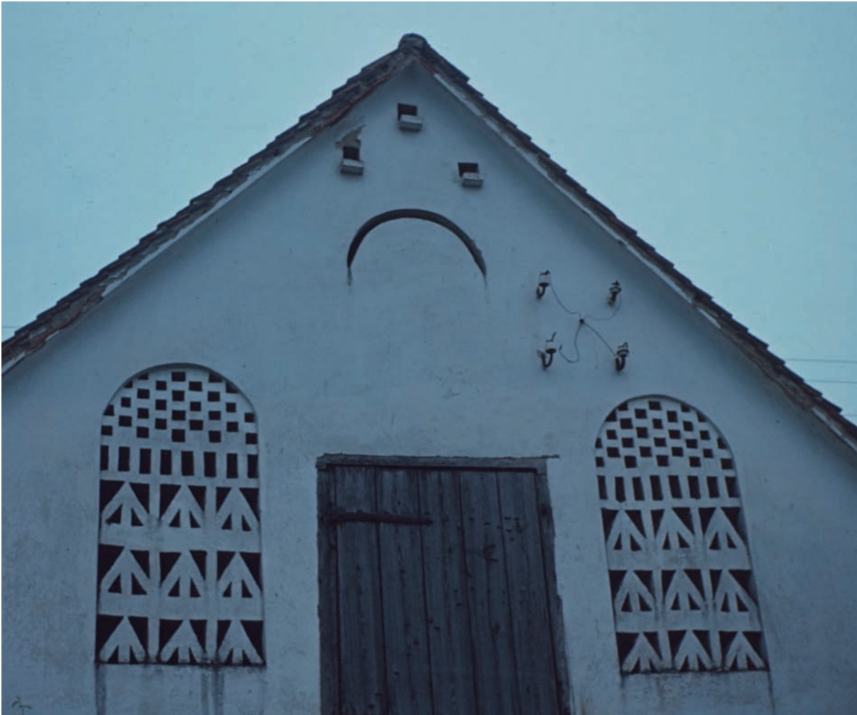
Abb. 248 In diesem Giebel mit Ziegelgittern in Rassach Nr. 27 finden sich mehrere interessante Architekturelemente. So gibt es direkt unter dem First einen kleinen Taubenschlag mit etwas vorkragenden Ziegeln, damit die Tauben leichter landen können. Darunter folgt eine sichelförmige Schlitzöffnung. Auf den Kopf gestellte Symbole bedeuteten früher das Gegenteil der ursprünglichen Bedeutung. Die Mondsichel wurde über Jahrhunderte und wird auch heute als Zeichen des Islam gesehen. Bei Muslimen handelt es sich es aber um eine durchhängende Mondsichel mit einem Stern darüber. Da es immer wieder Beispiele derartiger umgedrehter Sicheln in Ziegelgittern unter Firsten in der Steiermark gibt,
