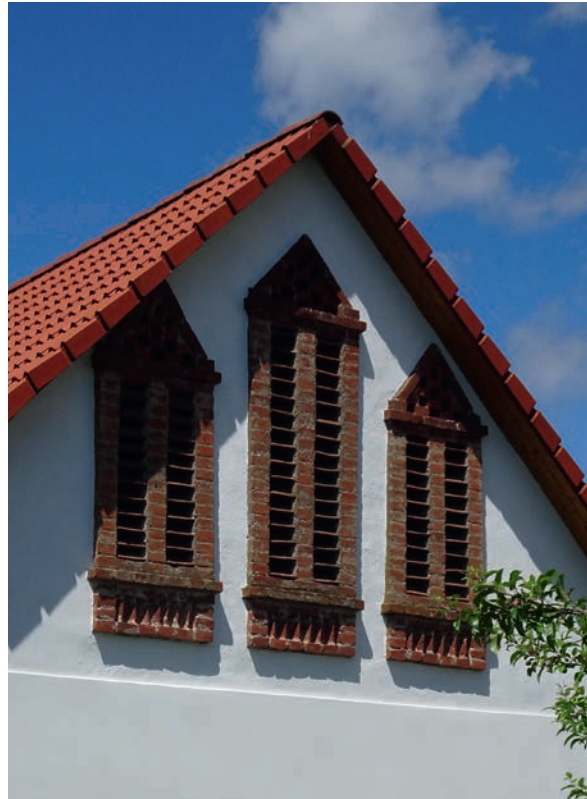
eine Art hohen schlanke Erker verpackt wurden. Die Ziegel wurden dabei mit einer leichten Neigung nach außen in die Schlitze vermauert, damit Regenwasser nicht ins Gebäudeinnere eindringen kann, sondern gleich wieder nach außen abfließt. Foto: 2020
