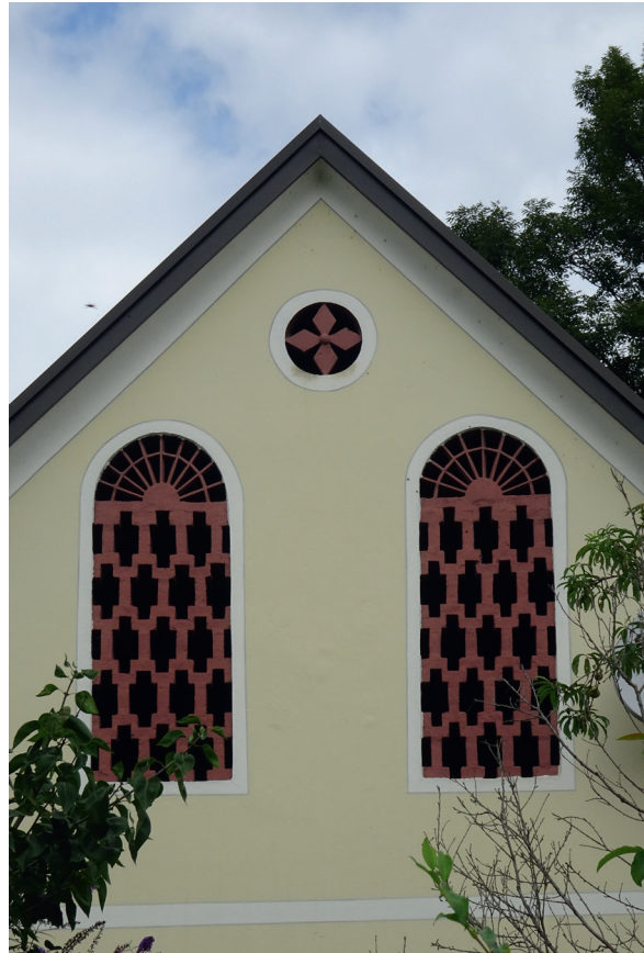
Abb. 224 Der Giebel mit zwei Rundbogenöffnungen und einer Rosette mit Ziegelgittern gehört zu einem Bauwerk am westlichen Ortsende von Fresing in der Sulmtal-Straße 50. Fresing liegt zwischen Leibnitz und Eibiswald. In der Rosette findet sich eine Blüte mit vier rautenförmigen Blütenblättern. In den zwei Rundbogenfenstern sind die Regelöffnungen kreuzförmig und unter den zwei Bögen geht die Sonne auf. Die Ziegel wurden offenbar miteinander verspachtelt und danach mit einer den Ziegeln im Farbton entsprechenden Farbe gestrichen. Ihre Oberfläche ist homogen. Weiße aufgemalte Faschen um die Ziegelgitter mit grauer aufgemalter Schattenfuge und ein weißer Rahmen auch um das gesamte Giebelfeld lassen den Hausgiebel sehr gepflegt aussehen. Foto: 2020
