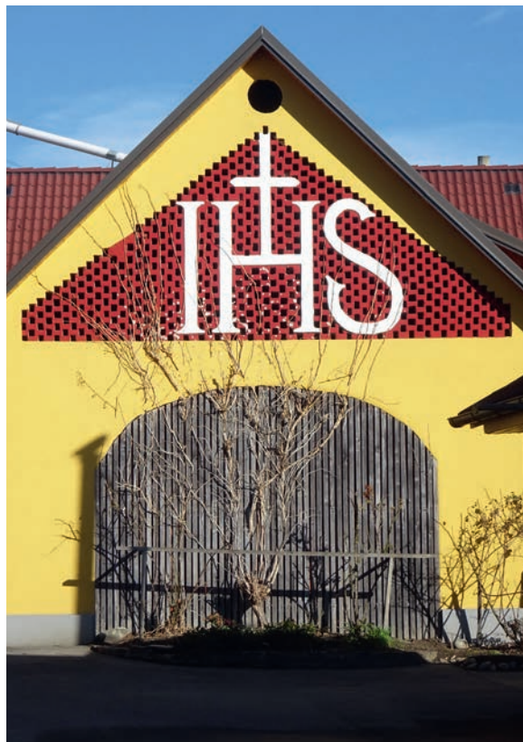
Abb. 136 Unweit des zuletzt besprochenen Gitters findet sich ebenfalls in Fernitz im Giebel des Wirtschaftsgebäudes an der Murberg-Straße 69 dieses in einen farblich abgesetzten Gittergiebel eingefügte IHS mit Kreuz. Auch hier besteht das Gitter aus mitgemauerten, tragenden Ziegelgittern mit einzelnen Lüftungsöffnungen. Giebel und Gittergiebel sind verputzt. IHS und Kreuz sind etwas stärker aufgeputzte Streifen, die weiß gefärbt wurden. Die Gitterzone erhielten dagegen ein Dunkelrot und die restliche Giebelfassade in einen gedeckten Beigefarbt. In einer kreisrunden Öffnung unter dem First ging offenbar eine frühere Rosette verloren. Foto: 2021
