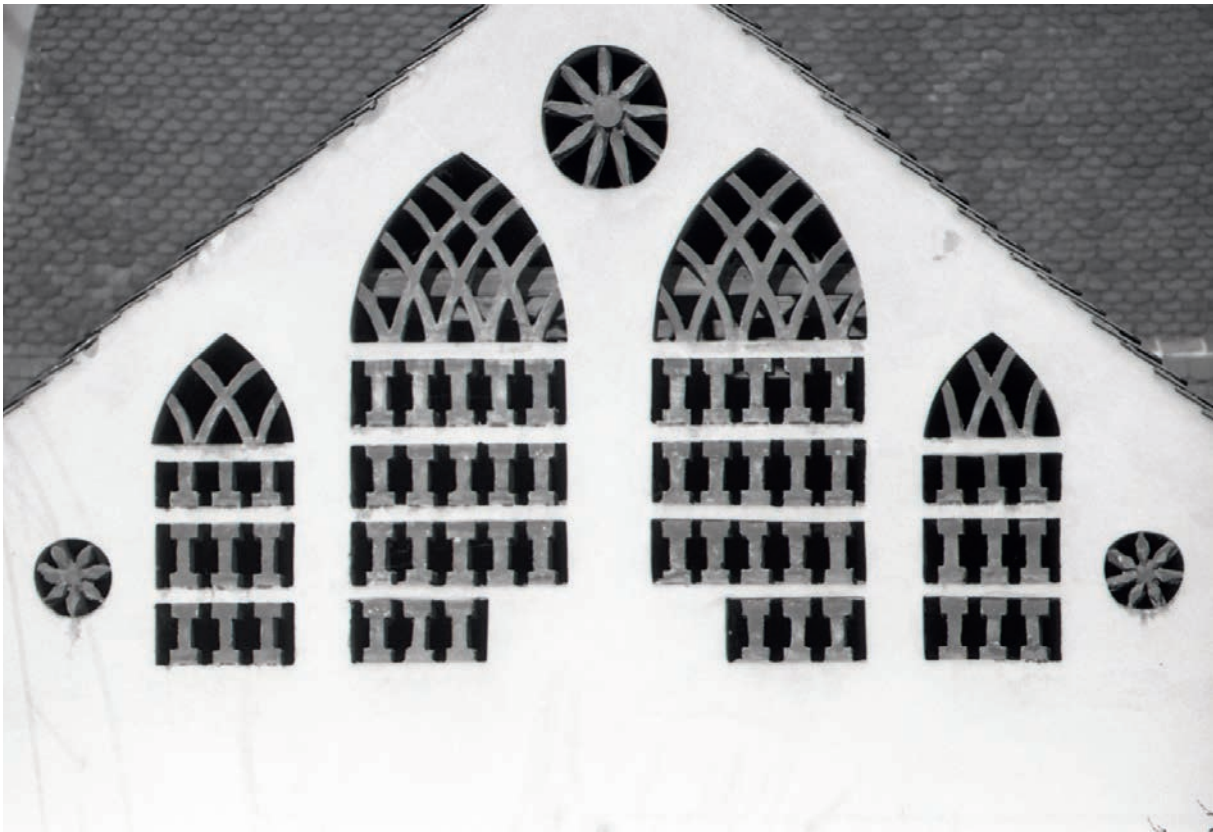
Abb. 186 Dieses Schwarzweißfoto des sehr ausgewogen gestalteten neugotischen Ziegelgitters in Fernitz entstand unmittelbar vor dem Erscheinen des ersten Buches über Ziegelgitter 1974. Es zeigt die etwas verzogene Rosette unter dem First und auch die Handwerklichkeit des Gitters, das si- cher von örtlichen Maurern errichtet wurde. Das Gitter war außen verputzt und erhielt mehrere vortretende horizontale helle Streifen. Foto: 1974
