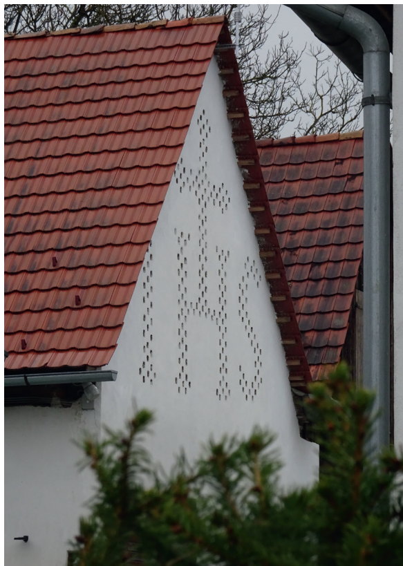
Abb. 135 Ebenfalls im Süden von Fernitz an der Murberg-Straße 79 findet sich im Giebel einer Stallscheune ein weiteres IHS, ebenfalls ganz in einzelne Lüftungsöffnungen, quasi in Punkte aufgelöst. Es ist ebenso verputzt, jedoch durch keine Kontur oder Farbe hervorgehoben. Auch hier steht auf dem "H" ein lateinisches Kreuz, hier allerdings mit Betonungen der Armenden. Foto: 2021
