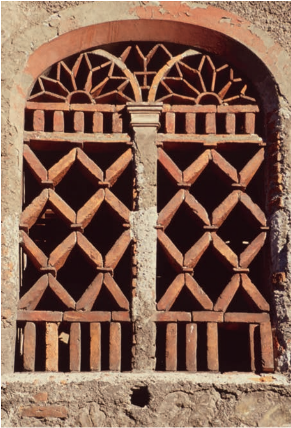
Abb. 214 Das Ziegelfenster in der Südfassade des Stadels in Mautern zeigt deutlich, mit wie viel Sorgfalt die Ziegel bei den Rauten jeweils mit einem horizontalen Stück Dachziegel aufeinander gemauert wurden. Im Zwickel der drei Bögen gibt es ein eingebautes Kreuz, das verhindern musste, dass der Feuerteufel durch die ungeschützten Öffnungen eindringt. Interessant ist auch die Mittelteilung des Gitters mit einem profilierten oberen Abschluss. Foto: 1999
