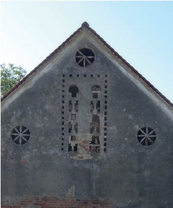
Abb. 150 In diesem Giebel eines älteren Wirtschaftsgebäudes in Hart bei Graz Nr. 198 nahe Pachern sorgen drei Rosetten und ein zentrales Gitter für die Durchlüftung. Die Rosetten waren jeweils von acht linsenförmigen Ziegeln geteilt. Das zentrale Gitter besteht aus zwei schlanken Gittertürmen, die von einer rechteckig geführten Linie aus einzelnen Lüftungsöffnungen oben und seitlich umlaufen wird. Bei beiden Gittertürmen handelt es sich wieder um das Kettenmotiv. Oben wird es hier jeweils durch einen kleinen Rundbogen abgeschlossen. Leider zeigt das Gitter schon etliche Schäden und müsste dringend saniert werden. Foto: 2021
