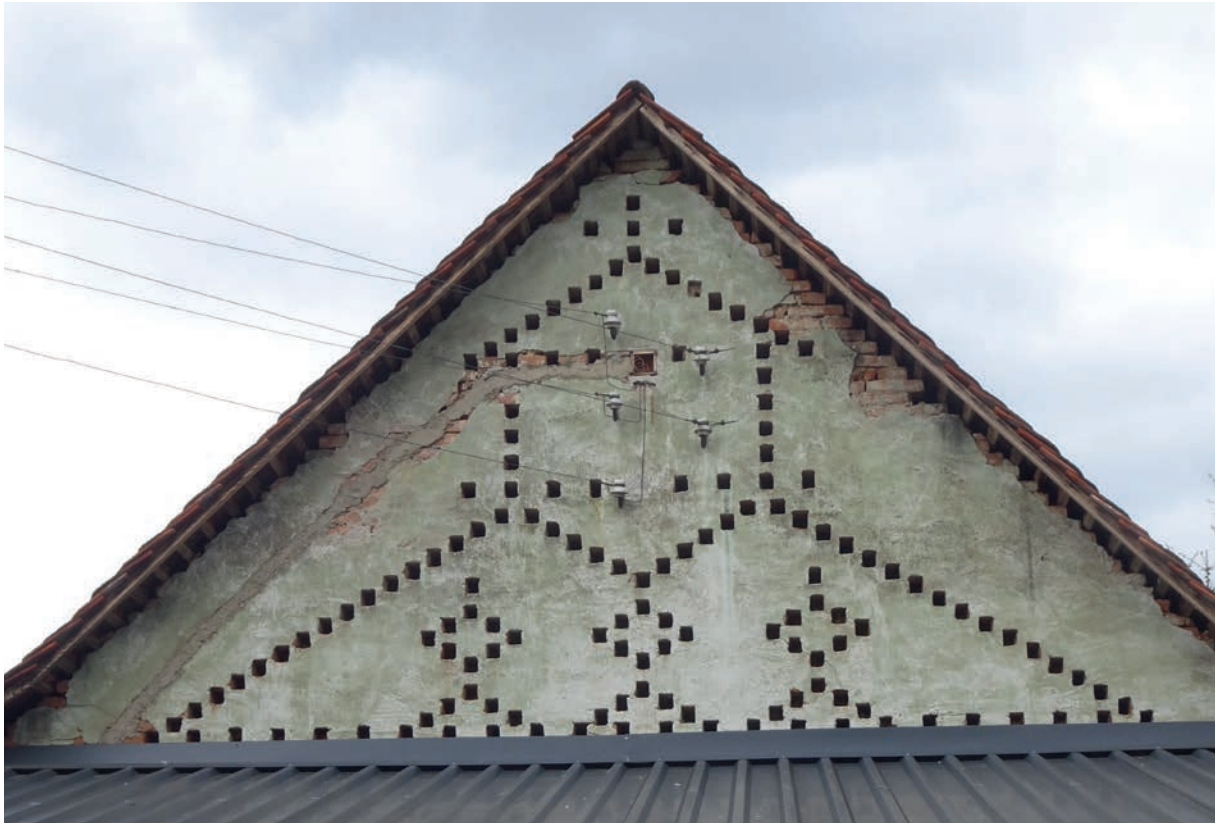
Abb. 68 Auf der Nordwestfassade des Wirtschaftsgebäudes in Liebendorf Nr. 45 sind oben im Giebeldreieck nur selbsttragende Gitter mit dem Bauwerk miterrichtet worden. Im Erdgeschoss hingegen finden sich vier sehr schlanke Gitterflächen mit einem gotisch wirkenden oberen Spitzbogenabschluss. Die oberen Gitter wirken wieder wie großflächige Textilien. Die unteren wurden in eine vorgefertigte Öffnung gestellt und sind als "Schrenkmaiern" anzusprechen. Unter dem Spitzbogen ist jeweils eine aufgehende Sonne mit fünf Strahlen aus Dachziegeln dargestellt. Alle Gitter dieser Fassade sind außen verputzt und ziegelrot gefärbt. Foto: 2017
