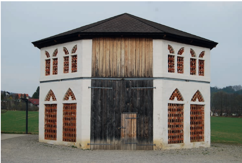
Abb. 203 Der Achteckstadel in Vasoldsberg von Nord- westen gesehen zeigt über dem Gesims mittig das kleine Tor zum Einbringen von Heu vom Heuwagen aus, wenn der untere Bereich des Stadels bereits voll war. Foto: 2008
