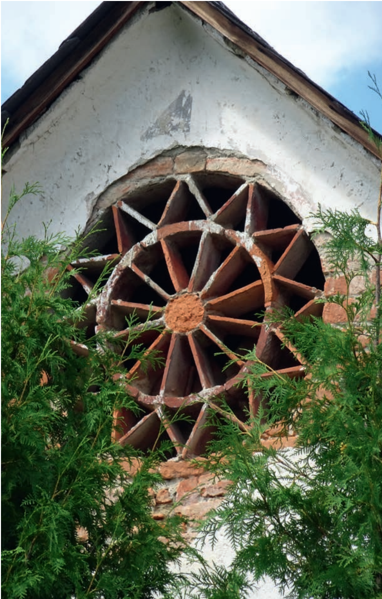
Abb. 326 Bei diesem Wirtschaftsgebäude in Gasselsdorf Nr. 25, Sulmeck-Greith, wurde eine Lüftung- rosette unter dem First eingemauert. Sie formt einen 12-strahligen Stern mit 12 Strahlen bis zum inneren Ring und 12 Zacken bis zur Laibung der runden Maueröffnung. Im Zentrum gibt es eine etwas stärkere Achse aus Ziegelmaterial. Foto: 2020
