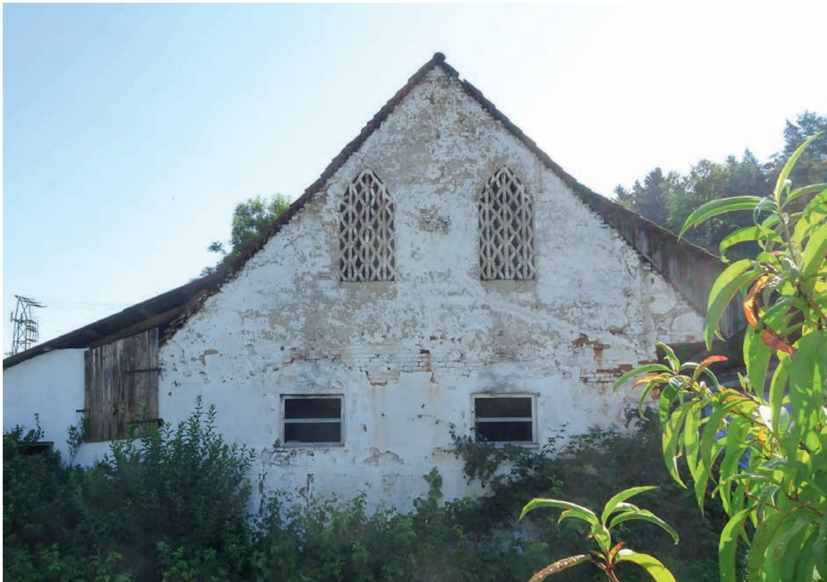
Abb. 192 Die kleine Stallscheune an der Dorfstraße 33 in Nestelbach bei Lassnitzhöhe verfügt über zwei oben spitz zulaufende neugotische Maueröffnungen, in die Ziegelgitter gestellt wurden, die aus jeweils drei geraden vertikalen Ziegelstreifen mit koordinierten Zickzackgittern jeweils rechts und links geformt werden, zwischen denen sich je Gitter zwei Spalten mit Rauten gebildet haben. Die Gitter weichen etwas gegenüber der Fassadenebene zurück. Gitter und Fassade waren ursprünglich verputzt und weiß überstrichen. Unter dem First scheint sich ein M zu zeigen. Hier könnten auch die Ziffern einer Jahreszahl angegeben gewesen sein. Foto: 2021
