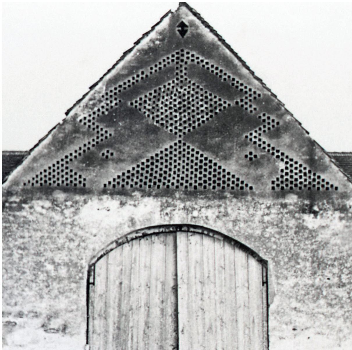
Abb. 48 Ein ganz ähnlich konstruiertes, tragendes Ziegelgitter in der Giebelwand dieses Wirtschaftsgebäudes in Heiligenkreuz am Waasen in Mirsdorf 4 spielt ebenso mit der seitlichen Dachneigung. Es ist nicht ganz exakt symmetrisch geformt und könnte fast als großflächiges modernes Kunstwerk gelten. Das Gitter war außen nicht verputzt, sodass der Ziegel bei Regen von außen durchfeuchtet werden konnte. Foto: 2021
