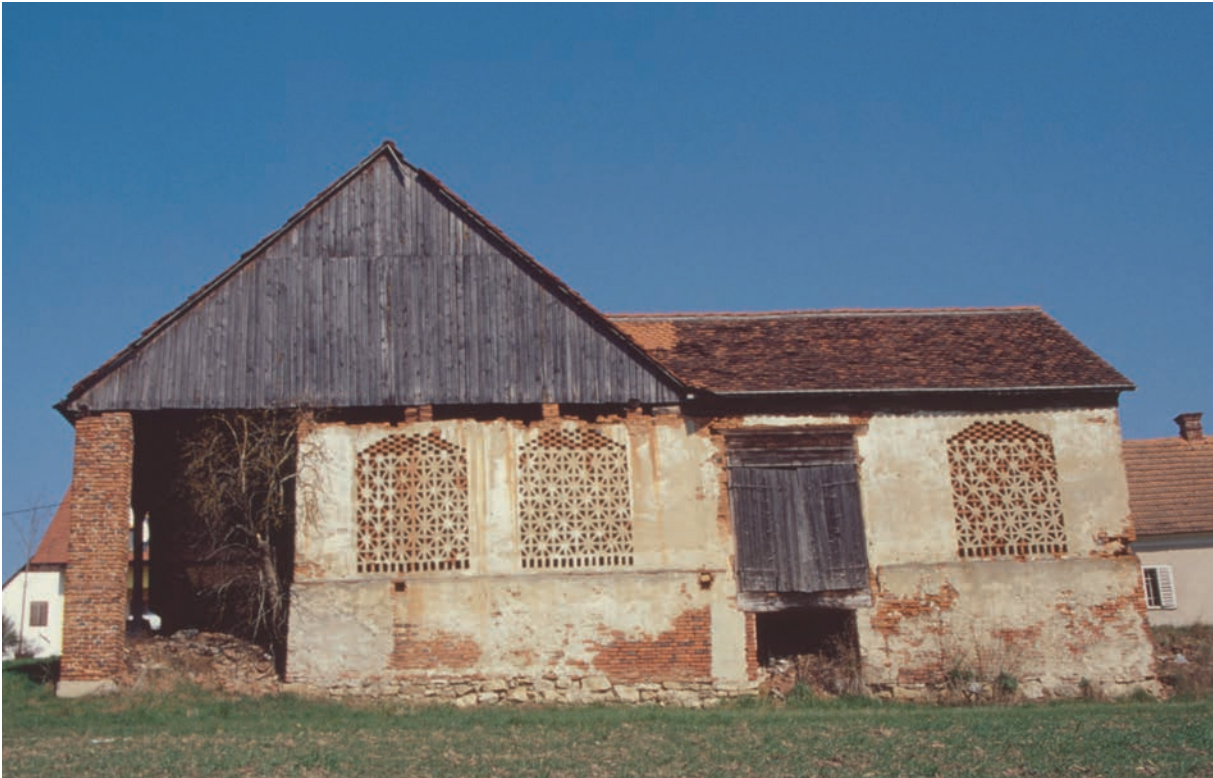
Abb. 31 Auch diese drei Ziegelgitter in einem Wirtschaftsgebäude in Hofstätten an der Raab sind selbsttragend in der Südwestfassade ausgeführt worden. Die schlichten Muster ergeben eine Art Sternenteppich mit Fransen unten und fast dachartigem Abschluss oben. Die Gitter wurden verputzt, hatten dadurch einen Regenschutz. Foto: 2002
