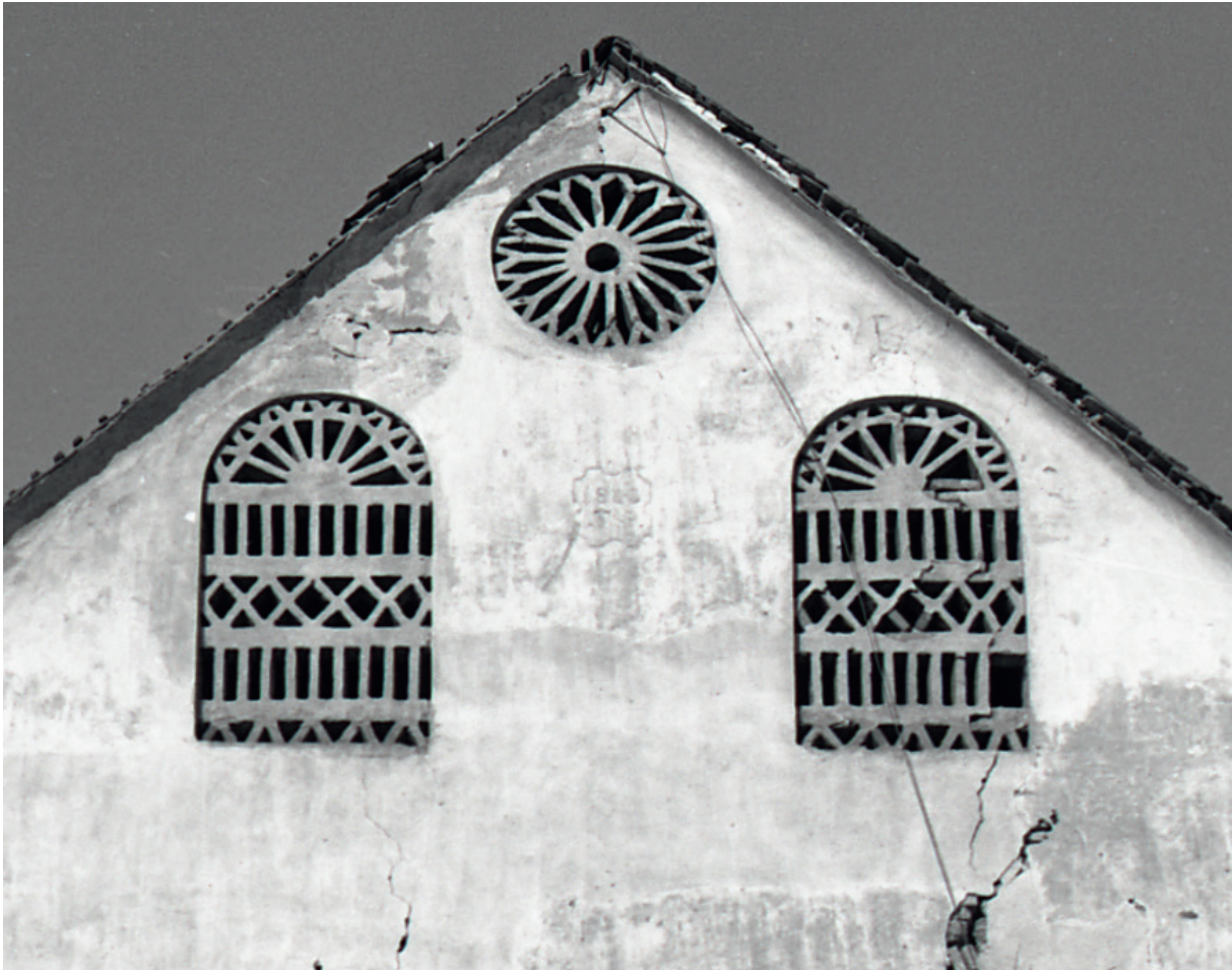
Abb. 256 Das Wirtschaftsgebäude in Pitschgau bei Eibiswald, Pollanzweg 17, wurde laut eingeputzter Informationskartusche unter der Rosette 1865 errichtet. Die Initialbuchstaben der damaligen Eigentümer waren I.T. P. 1973 warer der Bau und auch das Wohnhaus daneben unbewohnt und durch Vandalen war vieles beschädigt.
