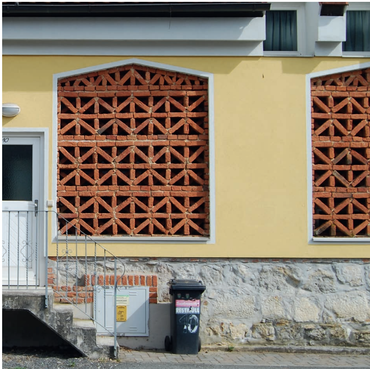
Abb. 30 Nach einer aufwendigen Sanierung und Adaptierung des Gebäudes in Mellach , Murbergstraße Nr. 252 und Amselweg 1 in Dillach ist inzwischen ein gastronomischer Betrieb mit Restaurant im Erdgeschoss und Fremdenzimmern im Dachgeschoss eingezogen. Foto: 2017
