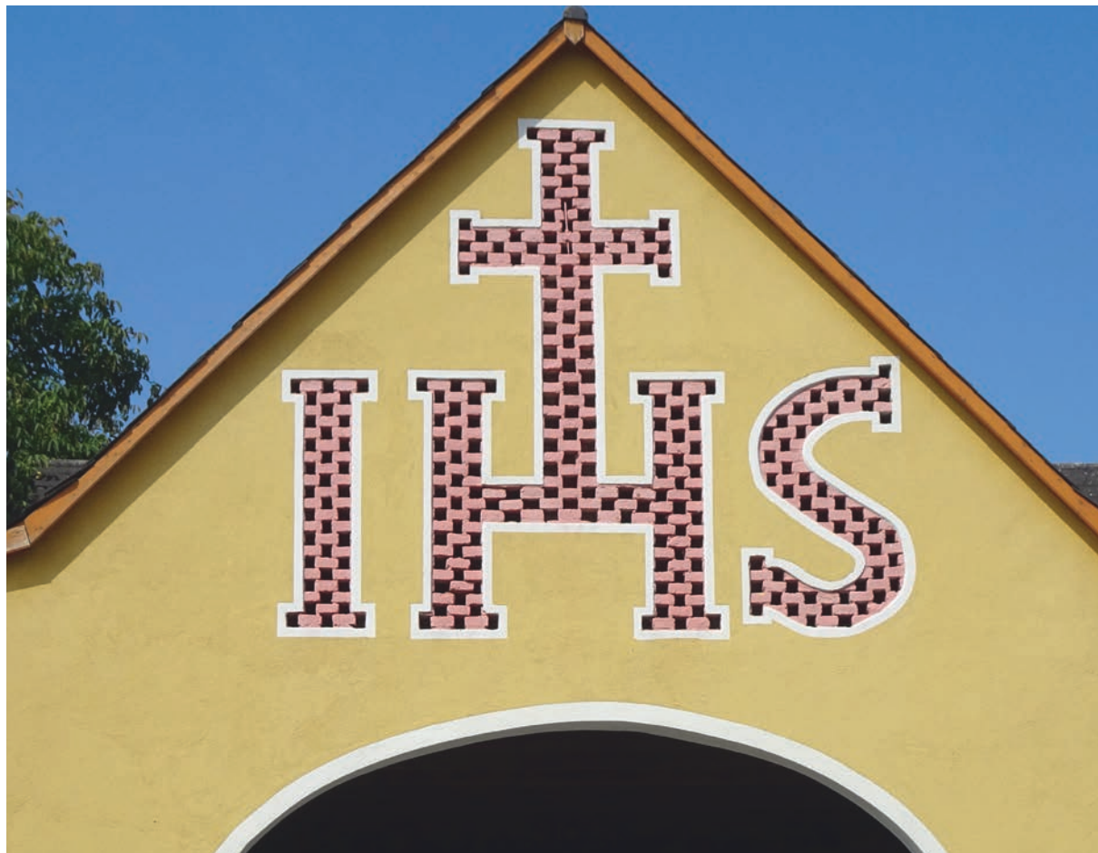
Abb. 132 Am Kapellenweg 9 in Großsulz südlich von Kalsdorf steht dieses landwirtschaftliche Objekt, das inzwischen für eine Nachnutzung adaptiert wurde. Das IHS mit Kreuz ist aber erhalten geblieben. Das nur aus tragenden Öffnungen bestehende Schriftgitter bildet in diesem Fall selbst die zwei christlichen Zeichen. Die Gitterfläche ist unverputzt, die Umgebung sorgfältig verputzt und in einem Beigelb gestrichen. Die Kontur der Buchstaben und des Kreuzes ist mit einer aufgemalten Art Fasche als Übergang zur Gitterfläche nachgezogen. Foto: 2018
