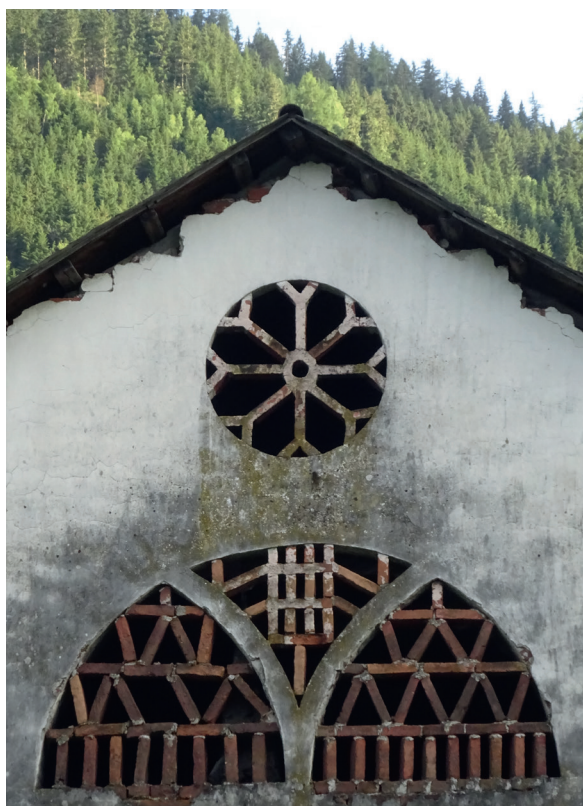
Abb. 246 Detail des Ziegelgitters in Murau . Leider kann man das Alter zwischen den zwei Gittern auf der Fassade nicht mehr eindeutig lesen.
