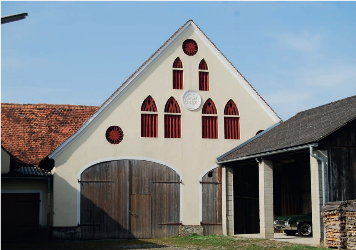
Abb. 191 Dieses Ziegelgitter in Gössendorf in der Dorfstraße 25 erinnerte schon von weitem gesehen angesichts der vielen Spitzbogenöffnungen an einen Sakralbau. Auch die Durchdringungen jeweils unter den Spitzbögen erinnern an das Maßwerk gotischer Kirchenfenster. Insgesamt finden sich sechs Spitzbogenfenster in dieser Fassade. Außerdem gibt es in den Eckpunkten des Giebelfeldes drei Rosetten, die an rote Blüten erinnern. Leider wurde die nördlichste von ihnen nun durch einen zu hohen und wenig anspruchsvollen Garagenbau abgedeckt. Foto: 2017
