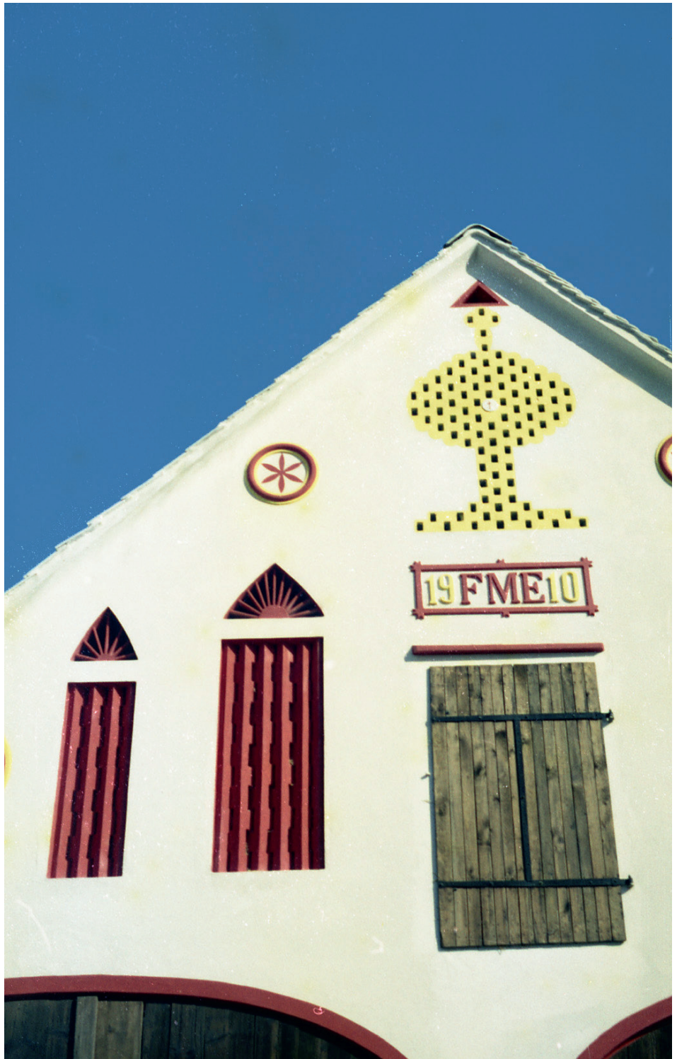
Abb. 296 Detail des farbig gestalteten Ziegelgitters in Thondorf südlich von Graz in einer kleinen Seitengasse der Bundesstraße 73 bei der Hausnummer 36. Foto: 1975
