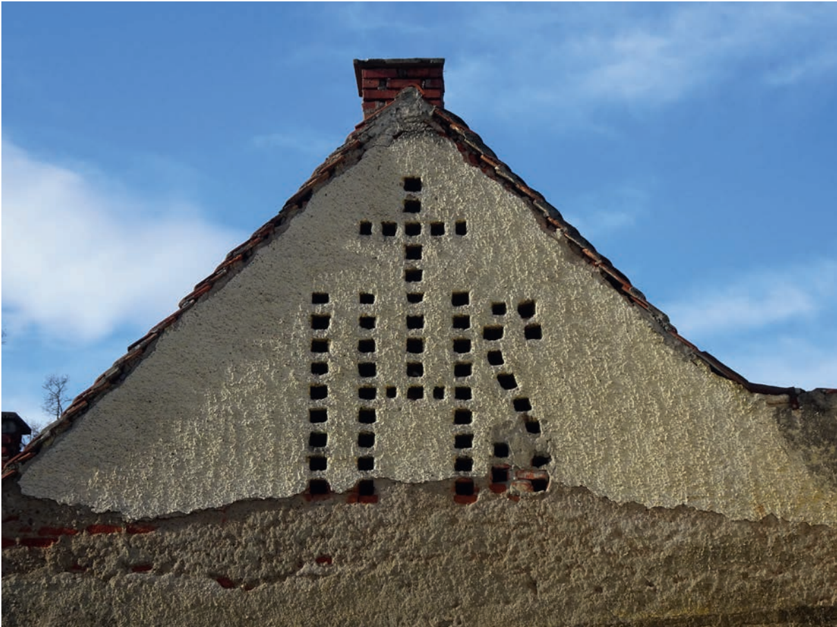
Abb. 123 Dieses Ziegelgitter im Giebel eines Wirtschaftsgebäudes in Graz-Liebenau in der Puntigamer-Straße 19 besteht ausschließlich aus einem sehr schlichten IHS und einem lateinischen Kreuz darüber und besteht nur aus einzelnen Lüftungsöffnungen, die während des Mauerns der Giebelwand freigelassen wurden. Als der Autor 1972 diesen Giebel das erste Mal fotografierte, war der hier im Bild fehlende Verputz unten ein alter Bestand und der hier im Bild zu sehende Spritzputz gerade erst neu aufgebracht worden. Foto: 2022
