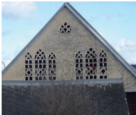
Abb. 185 Auch dieser kleine Stadl in Edelsbach bei Graz an der Edelsbacher-Straße 89 verfügt über ein Ensemble an Spitzbogenöffnungen im Giebel mit Ziegelgitterausfachungen. Leider wurde das Dach eines Anbaues so weit hinaufgezogen, dass die Gitter heute wie eingegraben wirken.
