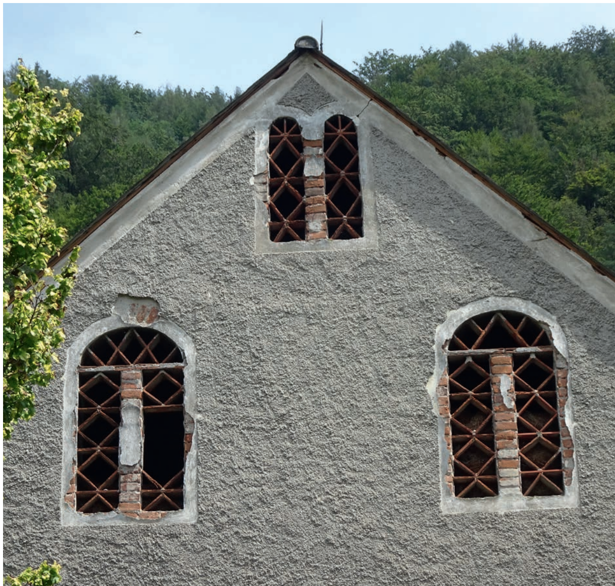
Abb. 16 Nicht immer bestehen Ziegelgitter aus Mauerziegeln. In diesem Fall wurden die Gitter unter dem First der ehemaligen Stallscheune in der Eggenfelder-Straße 24 in Eggenberg in Nordgratkorn ausschließlich von schlanken glatten Dachziegeln in vorgegebenen Rundbogenöffnungen geformt. Die Gitter mussten natürlich unverputzt bleiben. Foto: 2020
