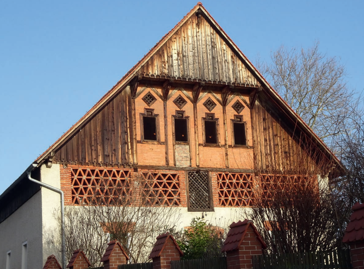
Abb. 58 Der Südgiebel des Wirtschaftsgebäudes in Kalsdorf , Dorfstraße 46 ging mit dem Abbruch des Gehöftes bedauerlicherweise ebenfalls verloren. Foto 2016
