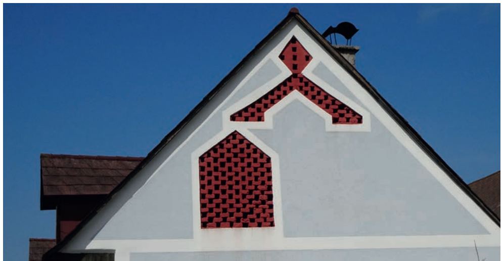
Abb. 73 Das einstige bäuerliche Wohnhaus in Großsulz bei Kalsdorf in der Großsulzer-Straße 26 deckte das Wirtschaftsgebäude dahinter mit Stallungen unten und Heubergeraum im Dachgeschoss nur zum Teil ab. So entstand zur Durchlüftung des Dachraumes beim Wirtschaftsgebäude nur ein "unvollständiges" Ziegelgitter. Selbst dieses hätte brandtechnisch durchaus problematisch werden können. Das Gitter selbst besteht nur aus tragenden einzelnen Lüftungsöffnungen, die unter dem First ein kleines Kreuz ergeben. Foto: 1972
