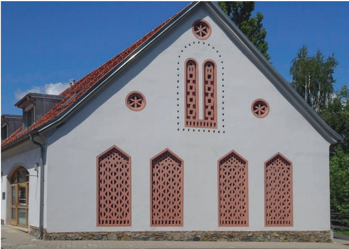
Abb. 146 Auch die Ziegelgitter an der Ostseite des heutigen Polizeigebäudes von St. Margarethen an der Raab hat der Adaptierungsplaner belassen und vorbildlich saniert in die Planung integriert. So konnte ein Stück Volksbaukunst der Steiermark hier erhalten werden.
