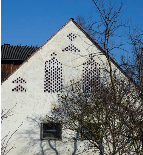
Abb. 143 Die Ziegelgitter im Giebel der Westfassade in der Engelsdorfer-Straße 41 in Graz-Liebenau bestehen ausschließlich aus kleinen Lüftungsöffnungen. Die tragenden Ziegelgitter formen an den Seiten jeweils zwei Dreiecke übereinander, die nach oben weisen. Drei weitere ähnliche etwas größere Dreiecke finden sich auch im Zentrum des Giebeldreiecks – zwei über den hohen rechteckigen Gitterfeldern, bei denen je ein kleines Kreuz den oberen Abschluss bildet und eines unter dem First, über dem noch ein rautenförmiges Feld folgt, das weitgehend sicher wieder eine Monstranz konturartig andeutet. Alle Gitter liegen in der Fassadenebene und sind verputzt sowie mit der Fassade weiß gefärbt. Foto: 2021
