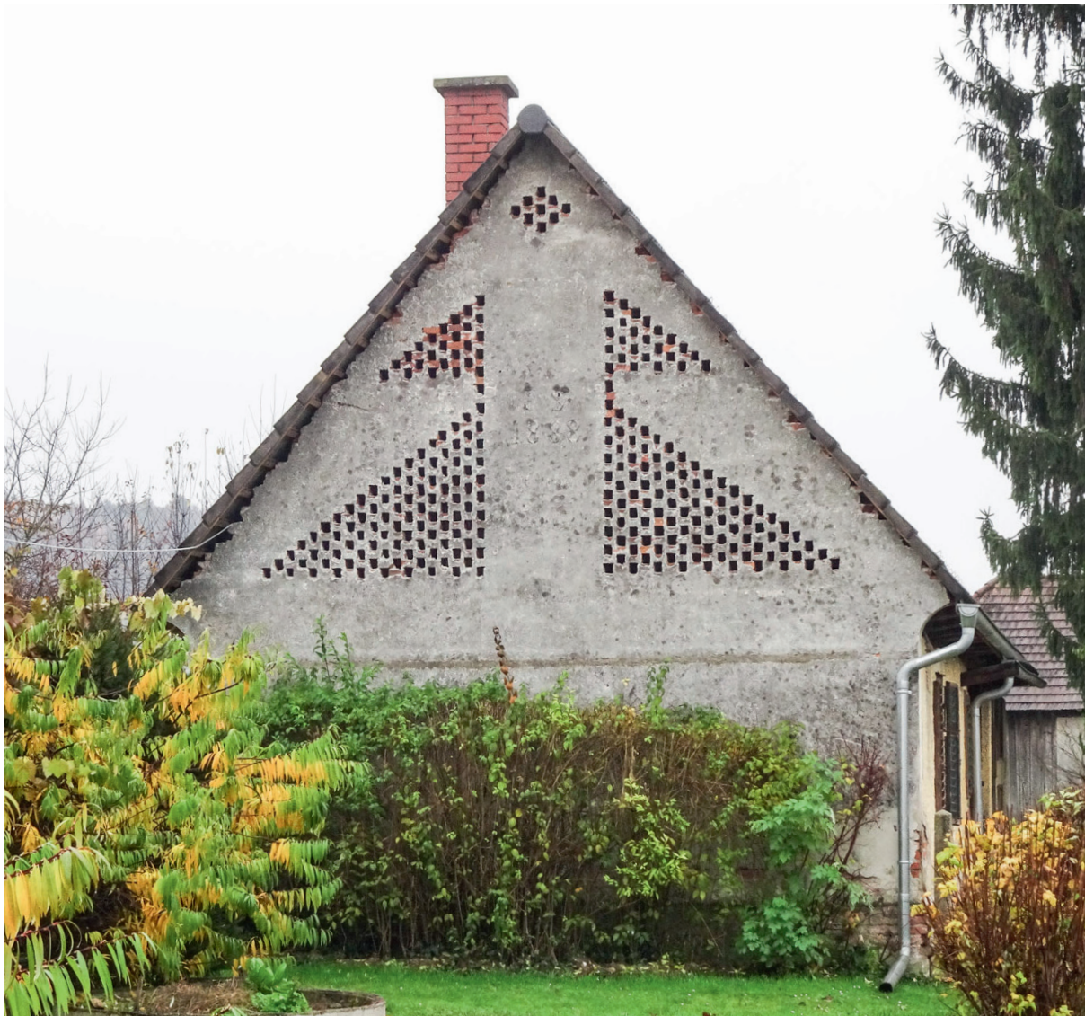
Abb. 54 Dieses recht kleine Ziegelgitterobjekt in Fernitz dürfte zum Anwesen Murbergstraße 59 gehören. Es besteht ausschließlich aus drei tragenden Gitterfeldern. Unter dem First liegt eine rautenförmige Gitterfläche rechts und links darunter folgen jeweils zwei dreieckige zusammenhängende Gitterfelder, die mit der Dachschräge etwas spielen. Dazwischen erkennt man sehr undeutlich die Initialbuchstaben wohl des einstigen Bauherren: S.S.; darunter ist das Jahr der Errichtung mit 1888 angegeben. Foto: 2021
