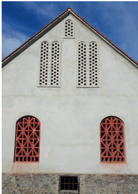
Abb. 265 In der Dorfstraße 21 in Wundschuh westlich von Kalsdorf finden sich diese Ziegelgitter bei Ge- höft vulgo Url. Oben sind es jeweils drei Spalten von einzelnen kleinen Lüftungsöffnungen, die jeweils von einem aufgeputzten Rundbogen- rahmen gefasst werden. Diese fünf Gitter kann man als tragende Gitter ansprechen, die mit dem Giebel mitgemauert wurden. Unten wurden in zwei Rundbogenöffnungen Ziegelgitter wohl erst sekundär eingemauert. Die oberen Gitter wurden verputzt und in der Fassadenfarbe gestrichen. Die unteren blieben unverputzt und erhielten eine dem Ziegel entsprechende Farbgebung. Foto: 2020
