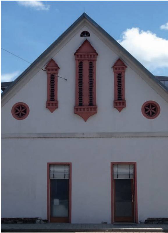
Abb. 104 Dieses Gebäude in St. Margarethen an der Raab mit der Nummer 39 gehörte ursprünglich zu einem Ensemble von Wirtschaftsgebäuden. Inzwischen wurde es zur Polizeistation der Gemeinde adaptiert. Dabei beließ man erfreulicherweise die architektonischen Qualitäten der Fassaden des Bauwerks, die Ziegelgitter, die einstigen Vorkehrungen zur Durchlüftung des Innenraumes, der früher als Heubergeraum genutzt wurde. Sie sind bei diesem Bauwerk in ganz besonderer Form ausgebildet worden und sicher als ein Beispiel der Volksbaukunst des 19. Jh. anzusprechen. Die Halbkreisöffnung unter dem First, die durch drei recht schlanke Ziegel über einem Firstziegel geteilt wird, ist in dieser Art öfter zu finden. Auch die zwei Rosetten in der Nähe der zwei Traufen mit einer Teilung durch sechs lanzettförmige Ziegel sind nicht wirklich ungewöhnlich. Das Besondere aber sind die vertikal geführten Ziegelgitter mit einer Dachziegelteilung, die in
