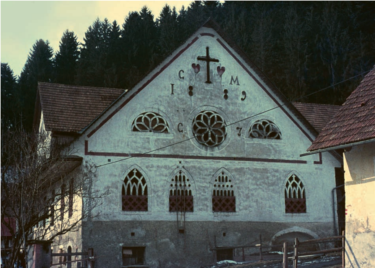
Abb. 3 Die große Rosette im Zentrum der Giebelwand der Stallscheune in St. Stefan bei Haimburg in Kärnten, Unterlinden Nr.1, steht frei in der Öffnung. Sie hatte einen Durchmesser von etwa 1,7 m. Foto: 1974
