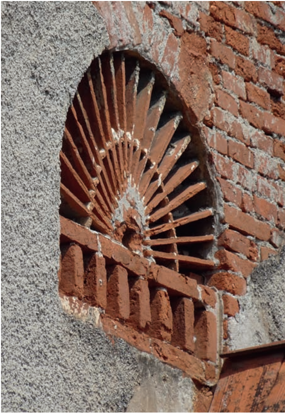
Abb. 317 Diese kleine Halbrossette entdeckte der Autor in der kleinen Ortschaft Eggenberg nördlich von Gratkorn in der Eggenfelderstraße 24. Sie besteht aus 19 Dachziegeln mit Abstandhaltern auf halber Strecke, die eingemörtelt wurden und einen zweiten Rundbogen formen. Auch hier gibt es eine einfache Lüftungsöffnungszeile als Basis. Die Halbrossette wurde erst sekundär in die fertige Maueröffnung gemörtelt. Foto: 2020
