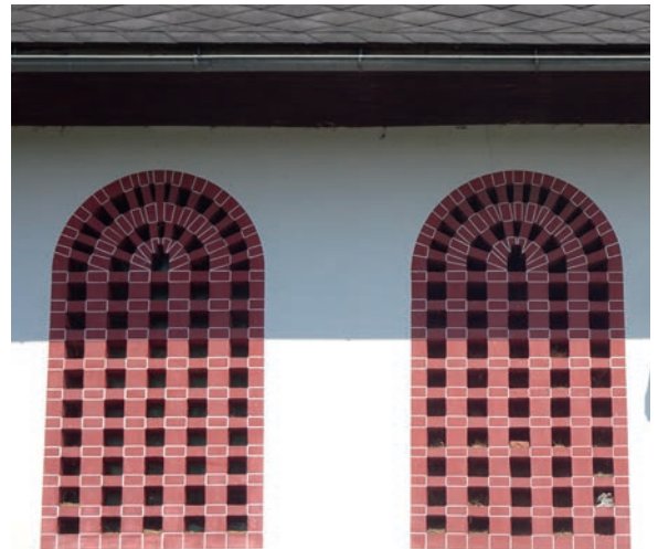
Abb. 261 Das Wirtschaftsgebäude in Flitsch neben dem Haus Nr. 10 bei Pirkwiesen wurde saniert, verputzt und besonders die Ziegelgitter in den Rundbogenöffnungen sehr sorgfältig bemalt. Offenbar wird der Bau immer noch zur Lagerung von Heu und Stroh genutzt. Zur Zwangsbelüftung an windstillen Tagen wurde zusätzlich ein Gebläse in die Außenmauer gesetzt. Foto: 2021
