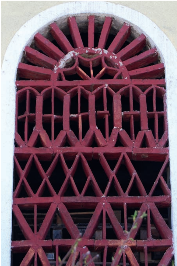
Abb. 223 Eines der Rundbogenfenster mit Ziegelgitterausfachung in einem sehr großen Wirtschaftsgebäude in Baumkirchen Nr. 1b in Rotwangl . Das Gitter ist recht vielfältig mit Mauerziegeln und Dachziegeln gestaltet. Möglicherweise wurden für den Inneren Bogen auch eigene gekrümmte Ziegel für die Gitter dieses Stadels geformt und gebrannt. Das spricht dafür, dass hier professionelle Handwerker, möglicherweise aus Friaul am Werk waren. Die Ziegel wurden nicht verputzt. Allerdings war der innere Bogen oben einst weiß und der Rest des Ziegelgitters rot eingefärbt, wodurch eine gewisse Imprägnierung der Gitterziegel entstand. Leider gibt es fast bei allen Gittern bereits zahlreiche Fehlstellen, die bei Gelegenheit ergänzt werden sollten. Foto: 2018
