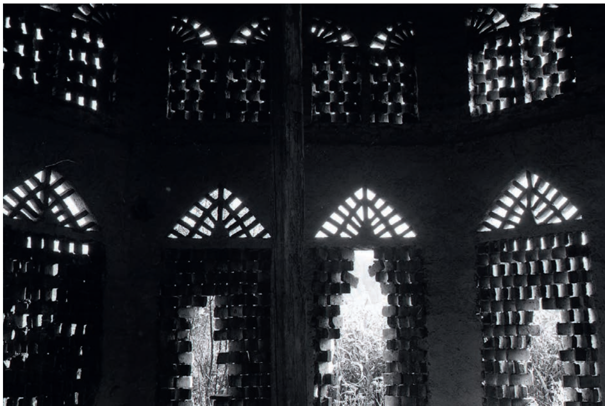
Abb. 200 Der Achteckstadel von Vasoldsberg von innen gesehen. Man sieht ganz links den etwas unbeholtenen Versuch einer Reparatur vor 1974 am linken Ziegelgitterfeld. Foto 1974
