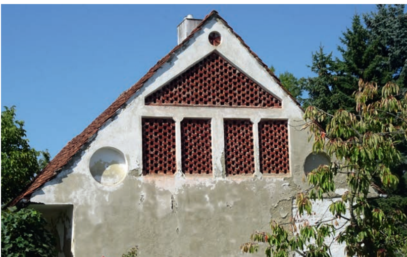
Abb. 71 Dieser Giebel in der Casalgasse 52 in Graz-Liebenau mit einem Ziegelgitter aus dem Jahr 1870 war mit drei geschlossenen Rosetten geschmückt. Die Rosette unter dem First ist etwas kleiner. Die zwei anderen an den Traufen trugen sorgfältig aufgeputzte große Blüten. Die Initialbuchstaben waren J, A und H. Als der Autor das Bauwerk 1974 fotografierte, hing hier bereits die Werbetafel der Tischlerei Wegscheider Leber. Die eigentlichen Ziegelgitter waren auf zwei große selbsttragende Flächen beschränkt. Foto: 1974
