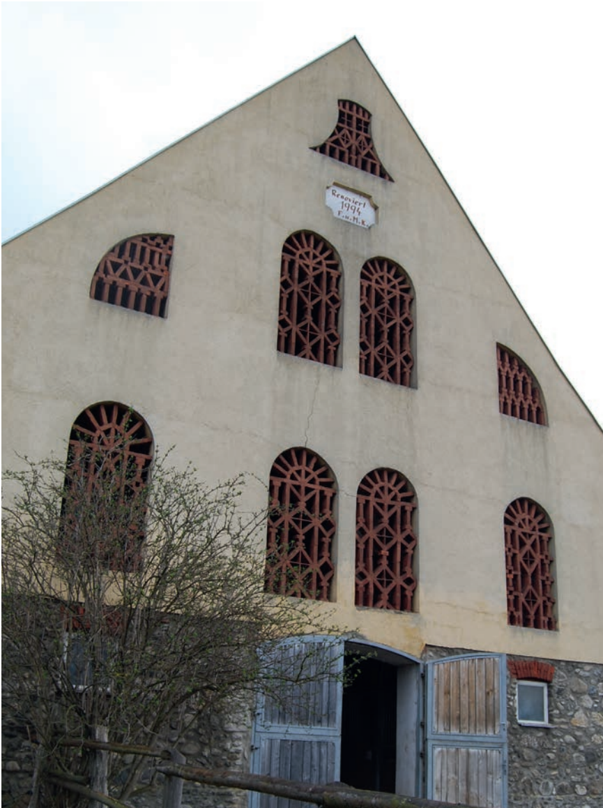
Abb. 254 Dieses 2018 aufgenommene Foto zeigt die gesamte Ostfassade der Stallscheune in Farrach in saniertem und rekonstruiertem Zustand. In der Kartusche steht inzwischen: "Renoviert 1994 F. u. M.K.". Man sollte überlegen, die sechs inneren Rundbögen in den Ziegelgittern wieder bis hinunter weiß zu färben, was ihnen eine zusätzliche Zartheit verleihen würde und dem Original entspräche. Foto: 2018
