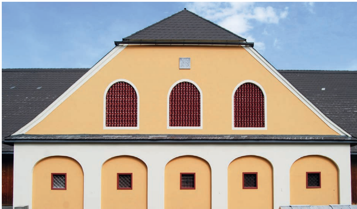
Abb. 269 Die große Stallscheune des sehr ausgedehnten Hofes in Thann am Weinberger-Weg und Oberreiter-Weg 5 in Maria Buch-Feistritz verfügt über große Ziegelgitterflächen in Form von "Schrenkmaiern". Der Hof wurde laut Tafel von S.A.E 1848 errichtet und 1981 das letzte Mal renoviert. Die Gitter in den Rundbogenfeldern wurden sorgfältig vermauert und dann die Ziegel rot und die Fugen dazwischen weiß angemalt. Foto: 2018
