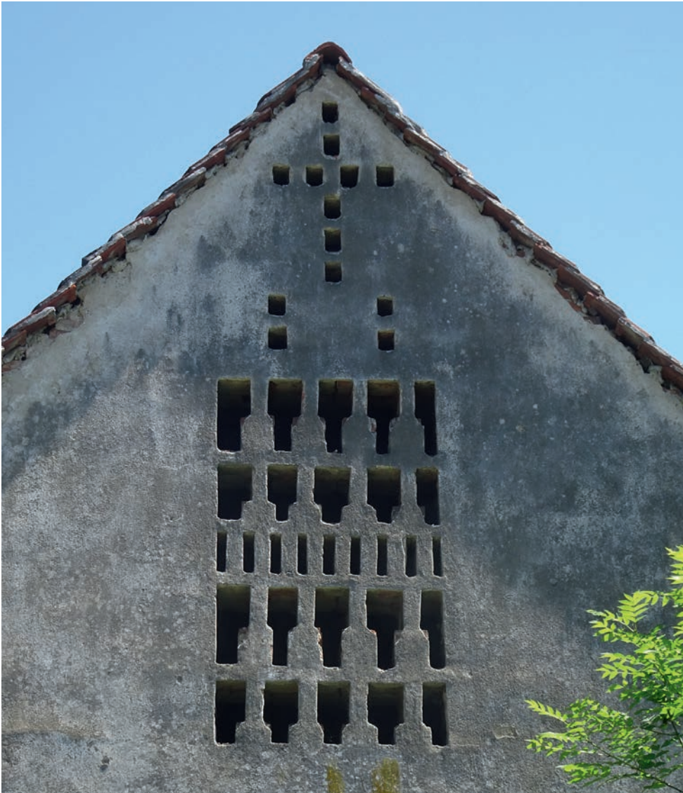
Abb. 79 Bei diesem Ziegelgitter in Pachern bei Graz in der Hauptstraße 59 hat offenbar jemand mit Ziegeln und mit Proportionen gespielt. Es handelt sich jedenfalls auch hier um ein tragendes Gitter, was man an den an der Untersicht des "Sturzes" gut erkennen kann. Hier wurden einfach nur lange Ziegel gestoßen auf das Gitter aufgelegt. Auch dieses Gitter ist zum Schutz gegen Durchfeuchtung bei Regen außen verputzt worden. Foto: 2020
