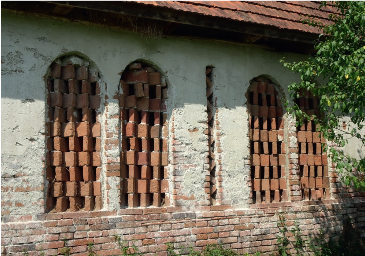
Abb. 14 Sogenannte "Schrenkmaiern" in vorgefertigten Rundbogenöffnungen eines Wirtschaftsgebäudes in Brodingberg in der Urschabach-Straße 36. Die Gitter bestehen aus seitlich aufgestellten Ziegeln, die unter 45° verdreht zur Fassadenrichtung so übereinander vermauert wurden, dass jeder Regelziegel auf drei unteren Ziegeln zu stehen kommt. Aus dieser Verschränkung der Ziegel entwickelt sich offenbar die Bezeichnung "Schrenkmaiern".
