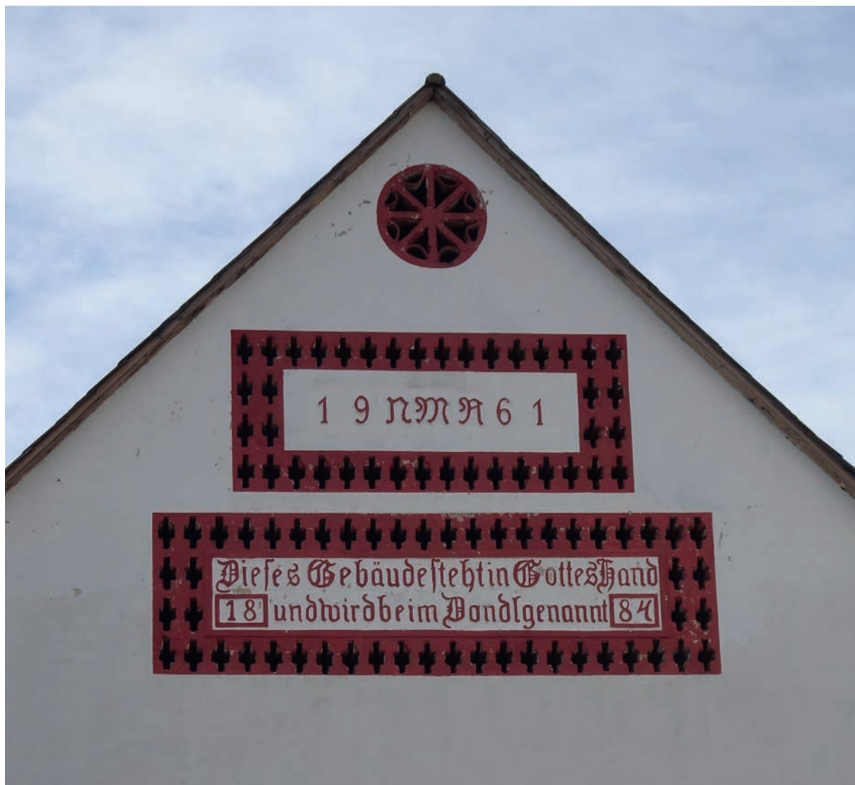
Abb. 82 Das Ziegelgitter dieses Giebels in Ponigl bei Wundschuh am Kapellenweg 11, Vulgo Tondl, besteht aus drei Teilen. Unter dem First gibt es eine Rosette aus acht Mauerziegeln und acht Firstkappen. Um die Rosette verläuft eine rote aufgemalte Fasche. Darunter folgt ein breites tragendes Gitterfeld mit kreuzförmigen Öffnungen, in das ein weißes Schriftfeld integriert wurde. Hier stehen die Initialbuchstaben N, M und R sowie die Jahreszahl 1961, die wohl das letzte Sanierungsjahr angibt. Nochmals mit etwas Abstand folgt ein noch breiteres,
