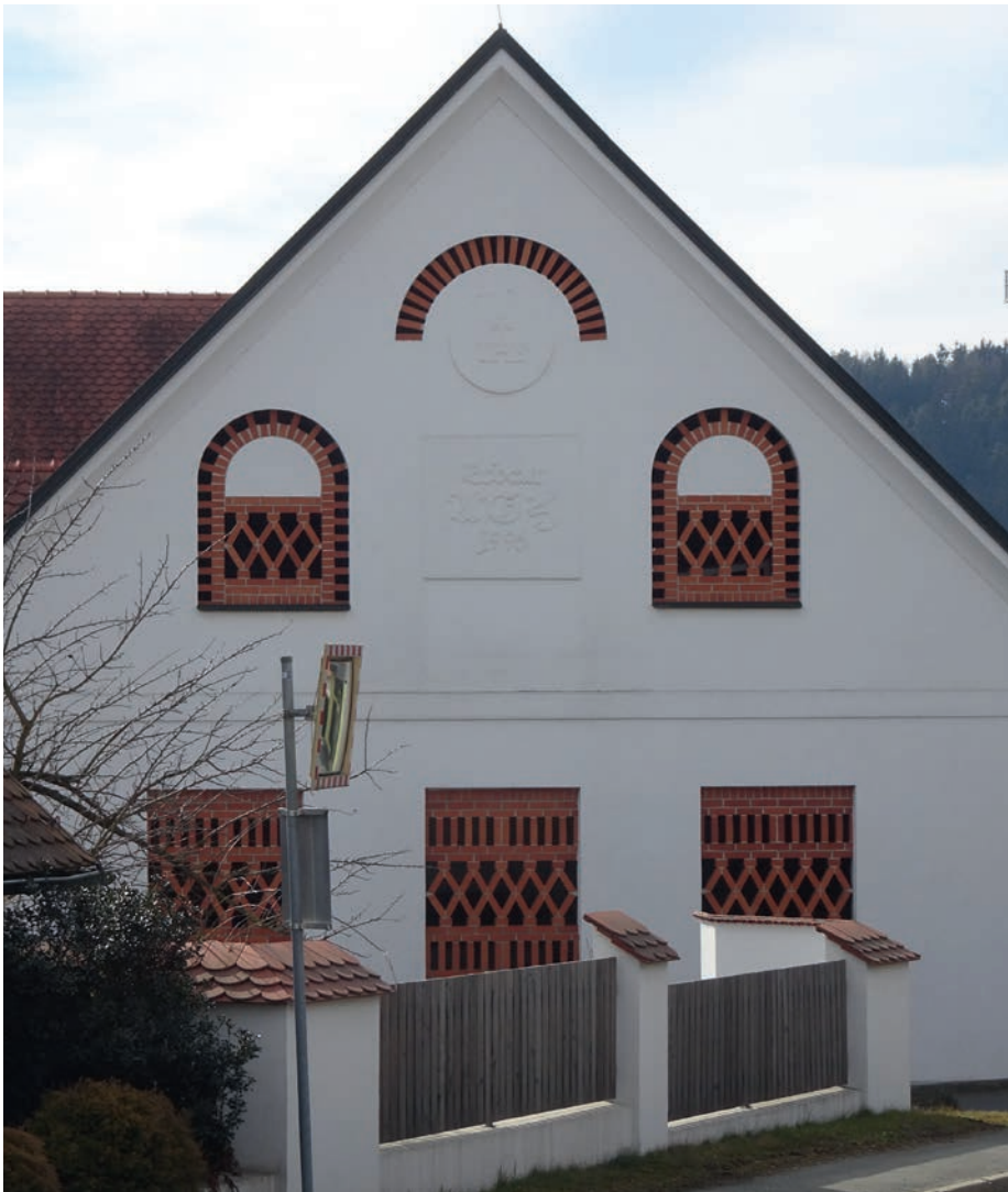
Abb. 340 Beim Haus "Am Dorfplatz 9 in Weitendorf bei Wildon wurden erst 1996 Ziegelgitter neu eingebaut. Sie wurden offenbar sekundär in vorher hergestellte Maueröffnungen gemauert. Auf einer kreisförmigen etwas vortretenden Putzfläche gibt es ein aufgeputztes Relief mit IHS und Kreuz. Auf einer weiteren etwa quadratischen vortretenden Putzfläche unterhalb steht "Erbaut U.G.S. 1996". Interessanterweise wurden bei diesem Bauwerk neue Massivziegel verwendet, die schon seit langem gewöhnlich nicht mehr hergestellt werden. Foto: 2020
