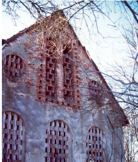
Abb. 151 Die Giebelfassade dieses großen Heuberges in Ungerndorf bei Gleisdorf nahe Hart wurde durch "Schrenkmaiern" in drei erdgeschossigen Rundbogenöffnungen und in zwei kreisförmigen traufnahen Maueröffnungen im Giebeldreieck sowie durch ein zentrales Gitter im Giebel durchlüftet. Das zentrale Gitter wurde in zwei schlanke hohe Rundbogenöffnungen gestellt und zeigt wieder je ein Kettenmotiv. Um diese zwei Gitter verläuft nochmals auf allen Seiten ein aus einzelnen Lüftungsöffnungen bestehendes Band in Form einer sehr großen Rundbogenöffnung. Schon 1993 war das Gitter ganz oben unter den zwei Rundbögen stärker beschädigt. Offenbar war die gesamte Fassade samt Gittern ursprünglich verputzt und so gegen Durchfeuchtung bei Regen etwas geschützt. Foto: 1993
