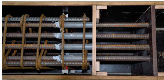
Abb. 3.7: Hüllrohre im Bereich der Spannkrafteinleitung bei Auflager B
