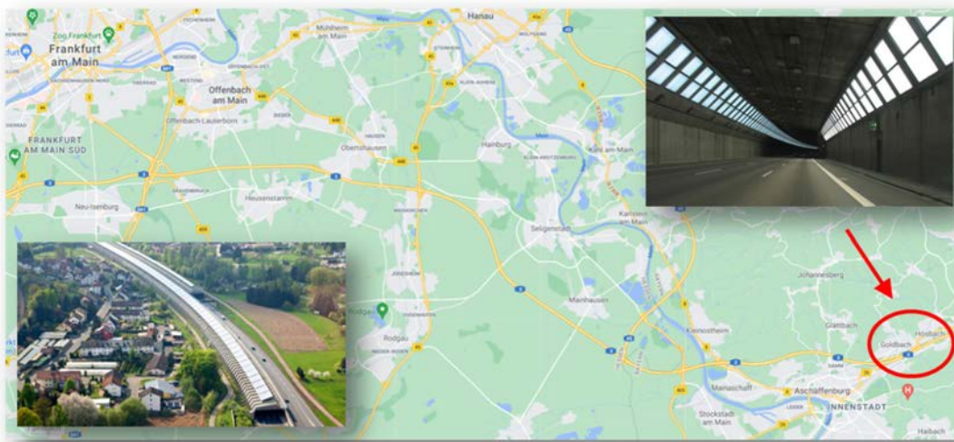
Figure 1: “Einhausung Goldbach-Hösbach”, Source: www.google.de/maps ; www.wikipedia.org/wiki/Einhausung_Hösbach
