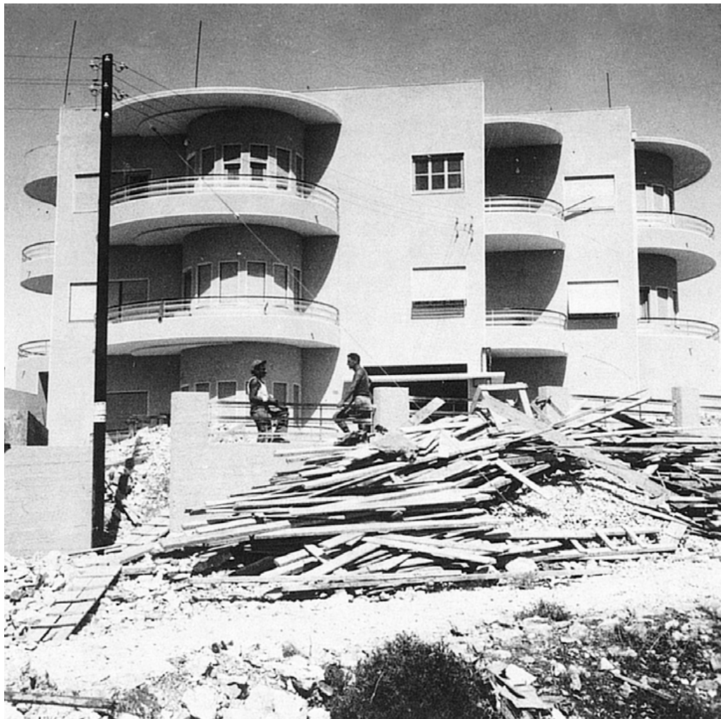
Haus Levin, kurz vor Fertigstellung
