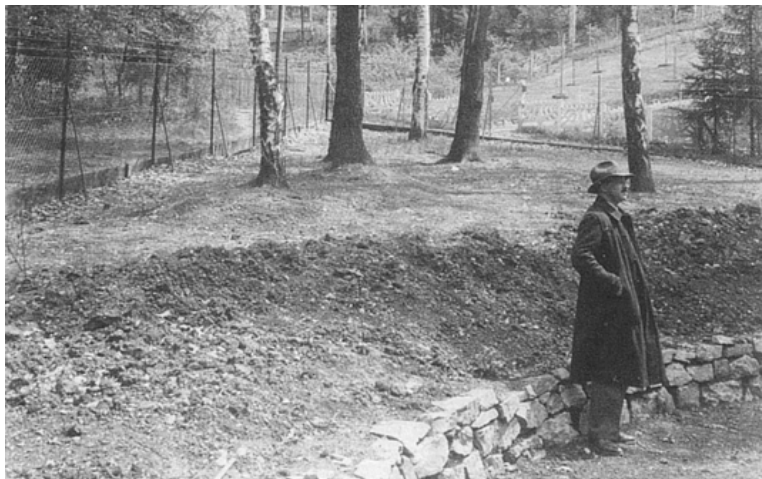
Karl Ilbing auf dem Bau- terrain, Juni 1932
