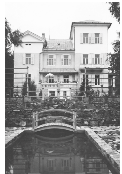
Ansicht des umgestalteten Hauses vom Garten aus
