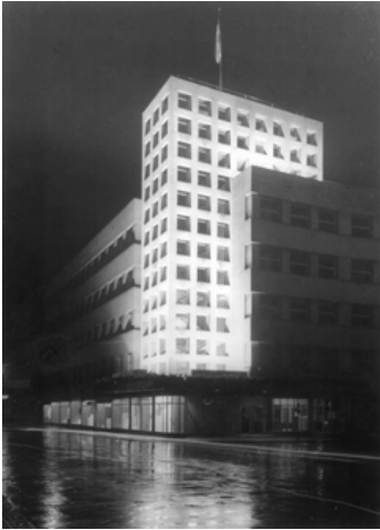
Links: Rambald Steinbüchel-Rheinwall, Verwaltungsgebäude der Grazer Gas- und Elektrizitätswerke, Graz, 1931–33
