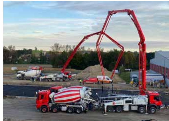
Abb. 42: „Betoneinbau von 880 m 3 mit zwei Betonpumpen“
