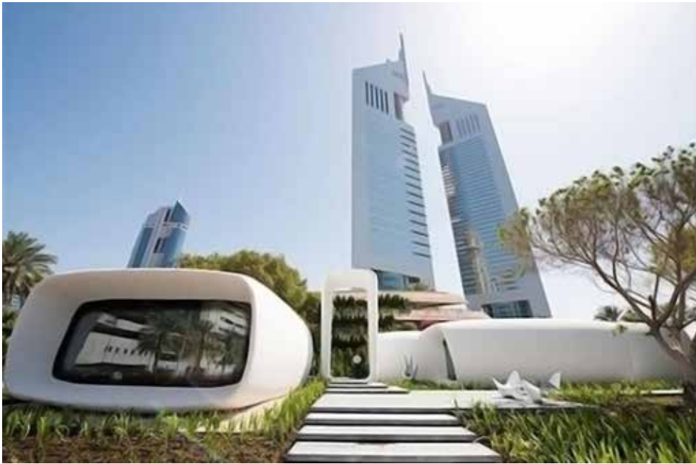
Abb. 13: „3D gedrucktes Bürogebäude“ 72
