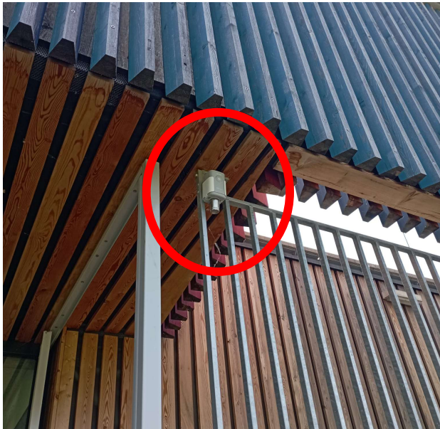
Abbildung 3-10. Beispiel für die Installation eines Außensensors (EM 500)
