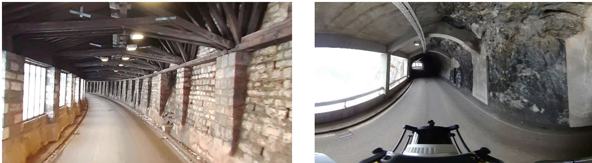
Abb. 5: Strukturelle Details der Flexengalerie. Die komplexe Geometrie und die wechselnden Oberflächen verdeutlichen die hohen Anforderungen an die Bestandsaufnahme.
