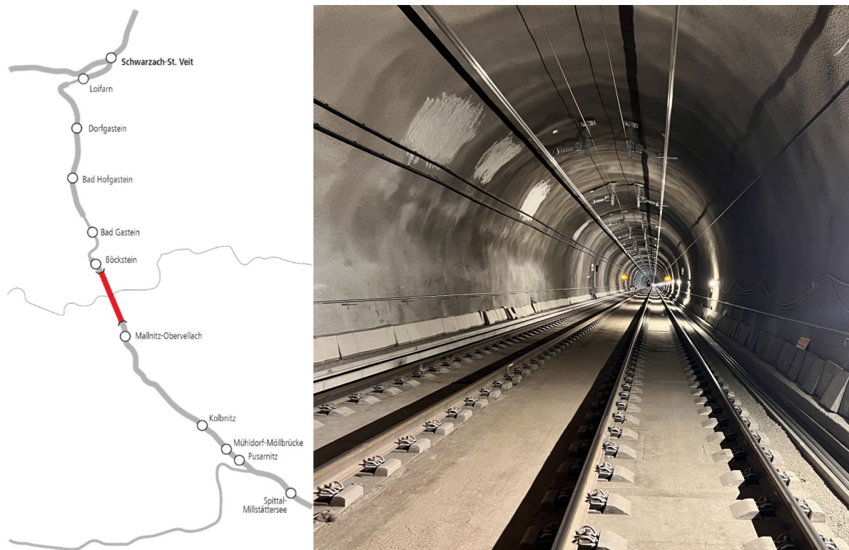
Abb. 1: a) Übersicht der Tauernstrecke im Abschnitt Schwarzach St. Veit und Spittal-Millstättersee (ÖBB Infrastruktur AG) b) Tauerntunnel Juni 2025, 3 Wochen vor Wiedereröffnung (VSP Stolzka & Partner)
