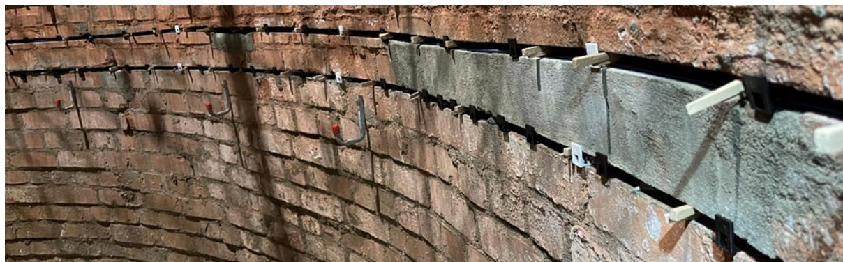
Abb. 5: Geschlitztes Schachtmauerwerk (oben Messhorizont 1, unten Messhorizont 2).
