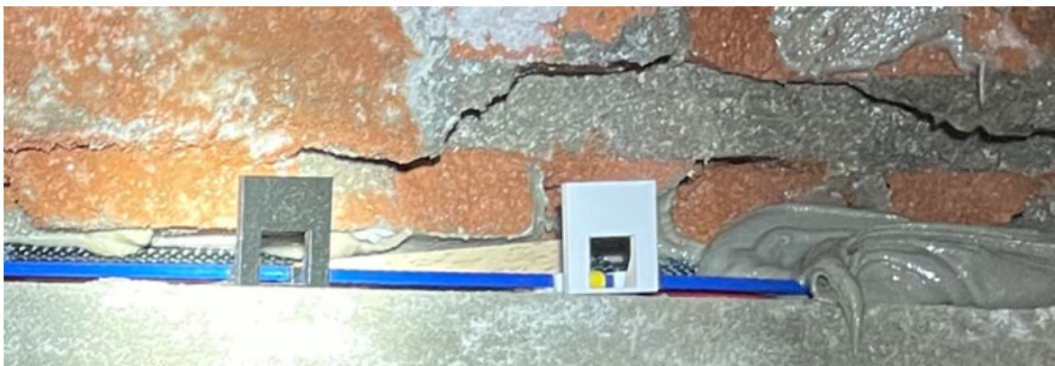
Abb.7: Messhorizont mit Abstandshalter, Faserkabel und Verbundwerkstoff.
