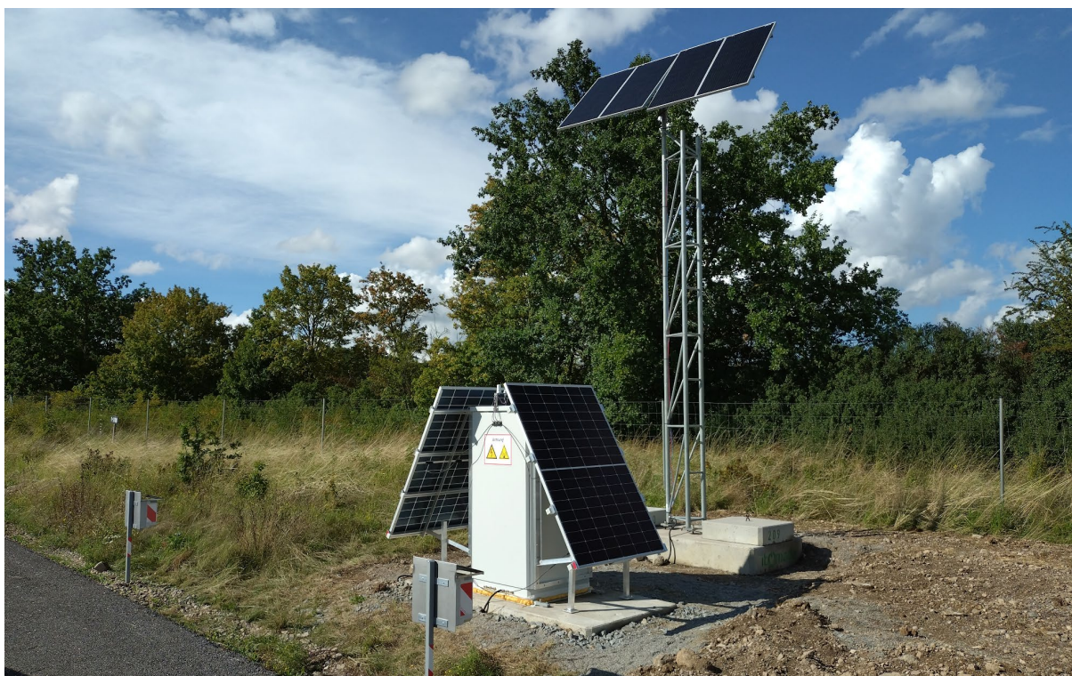
Abb. 5: Monitoring-Station mit PV-Inselanlage während der Installation an der Autobahn A4
