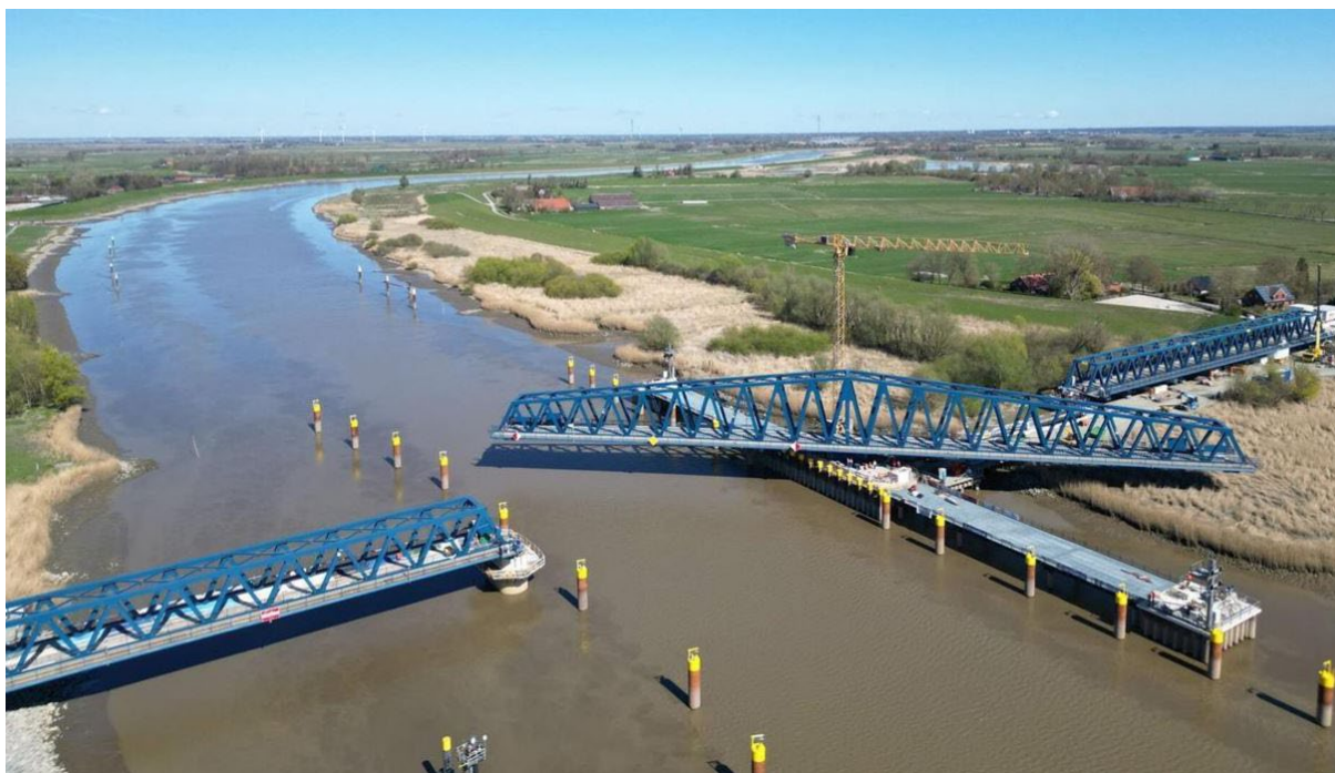
Abb. 4: Neue Friesenbrücke beim Drehvorgang
