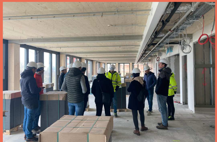
Exkursion LeopoldQuartier, Vienna Baustellenbesuch
