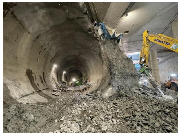
Abbildung 2 Abbruch eines temporären Widerlagers (Quelle: BOKU)
