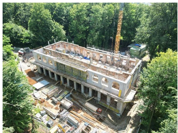
Abbildung 1 Im Bau – 1.OG [2]
