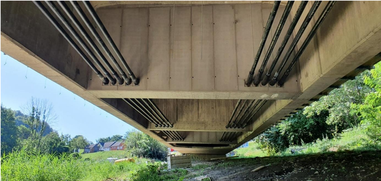
Abbildung 9 Tragwerksuntersicht mit externer Vorspannung in Bauphase 2
