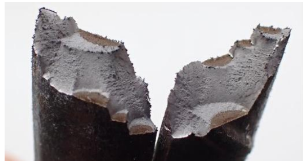
Abbildung 6 Maximal geschädigter Einzeldraht aus den Feldbereichen der Brücke 1. Der Gesamtbruch erfolgte versetzt in mehreren Ebenen.
