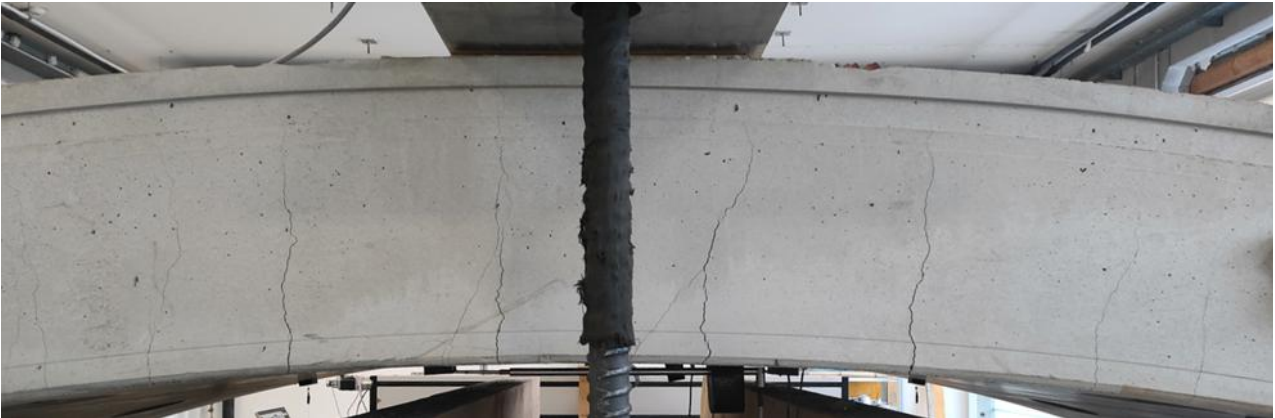
Abbildung 6 Aufnahme einer Tübbingseite mit Basaltbewehrung zur Darstellung der Rissverteilung
