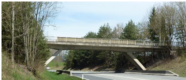
Abbildung 1 Bestandsstragwerk vor dem Sicherheitsausbau
