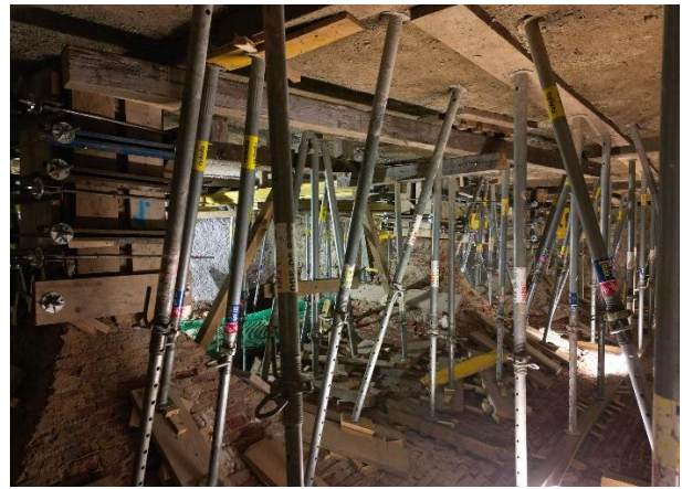
Abbildung 7 Sicherungsunterstellung des Gewölbes [13]
