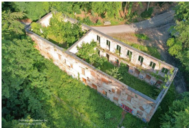
Abbildung 2 Zustand der Ruine vor Beginn der Arbeiten [8]
