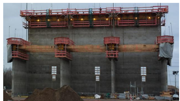
Abbildung 5 Gleitschalung aller Brandwände (7 Tage)
