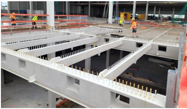
Abbildung 7 Verbundhauptträger, Verbundnebenträger und Elementdeckenmontage Foto: Bergmeister Ingenieure
