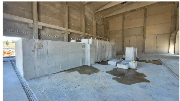
Abbildung 15 Das fertiggestellte Kompressorfundament
