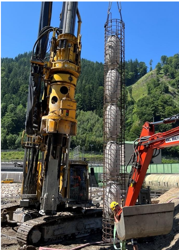
Abbildung 10 Einbringen des mit Aussparungskörpern bestückten Bewehrungskorbes
