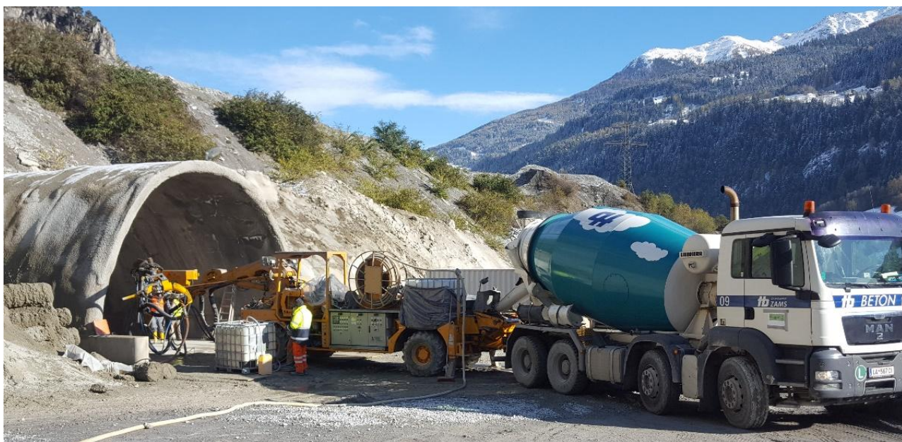
Abbildung 4 Spritzversuche bei der TB Betonwerk Zams GmbH
