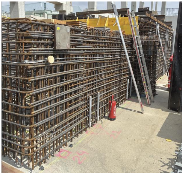
Abbildung 14 Bewehrung der aufgehenden Sockel
