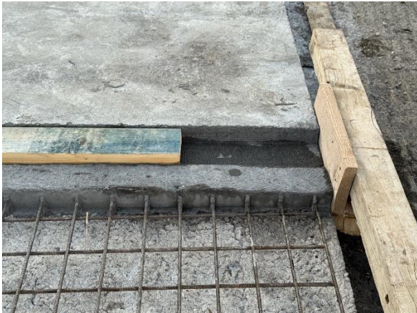
Abbildung 4 Ausbildung einer Fuge nach SIA 2052:2016
