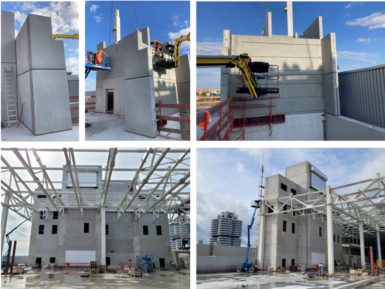
Abbildung 5 Baustellenbilder Montage AUS002 im OG2: Montage einzelner U-Wände bis fertige Montage mit Stahlbau. Fotos: Bergmeister Ingenieure
