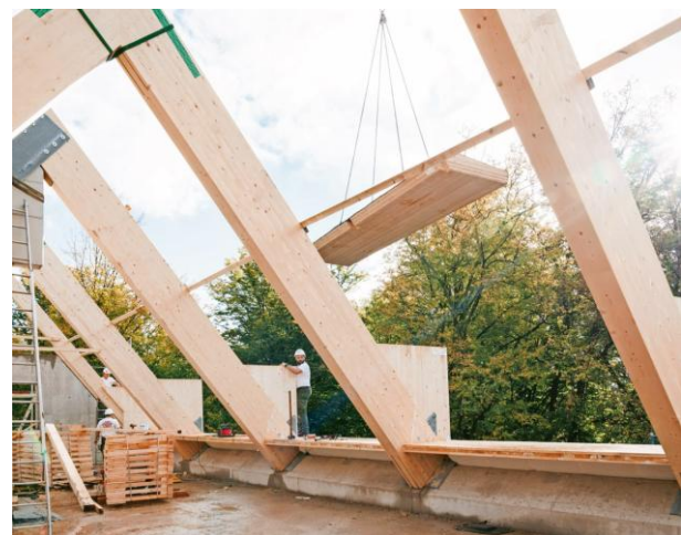
Abbildung 14 Dachkonstruktion – Hauptrahmen und Gaupe [5]
