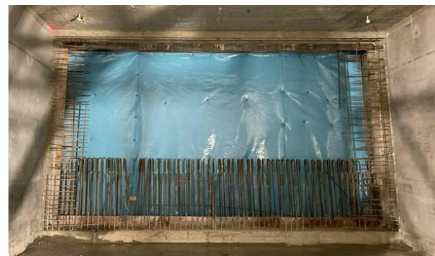
Abbildung 4 Aussparung für die Prototypenwand im 5. UG des Bauwerks "Notausstieg Quellenstraße"
