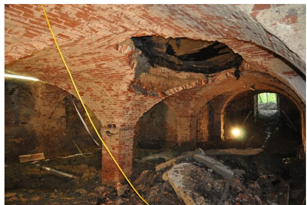
Abbildung 4 Gewölbeeinsturz [13]
