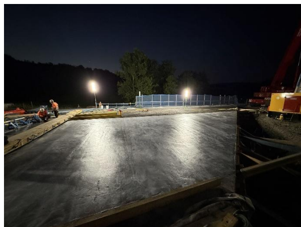
Abbildung 6 Fertiggestellte UHFB-Schicht
