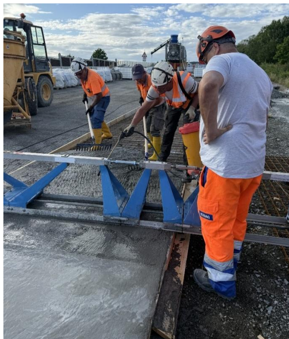
Abbildung 3 Herstellung Mock-up unter Baustellenbedingungen
