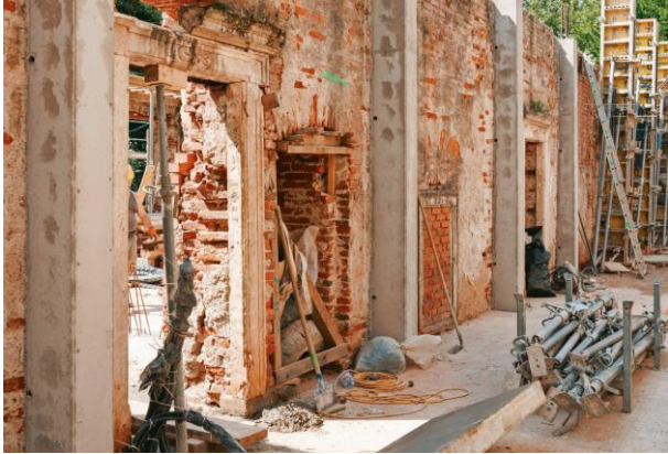
Abbildung 11 Stahlbeton-Lisenen (Innenskelett) [5]
