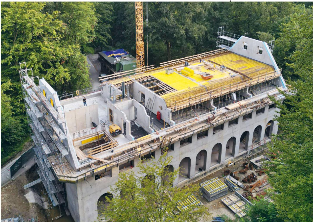
Abbildung 15 Baufortschritt – 1. Dachgeschoß mit Stahlbetonscheiben und Sargdeckel [2]
