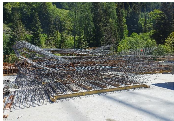
Abbildung 4 Vorgefertigte Bewehrungskörbe am Lagerplatz obertage
