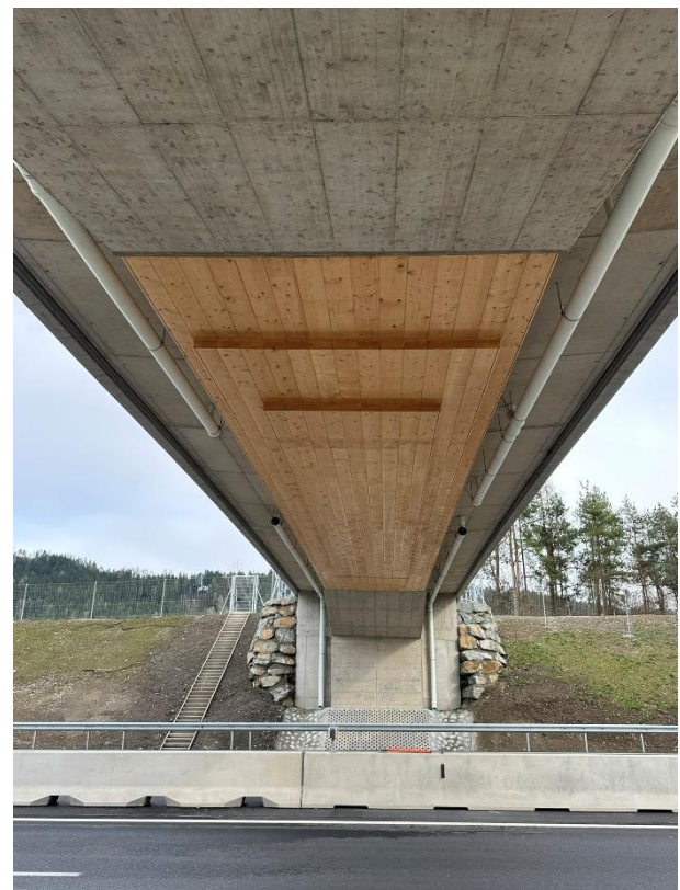
Abbildung 12 Untersicht des Tragwerks
